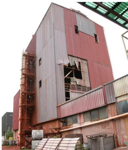
Slika 4: Posledica eksplozije plina v peči za regeneracijo kisline
