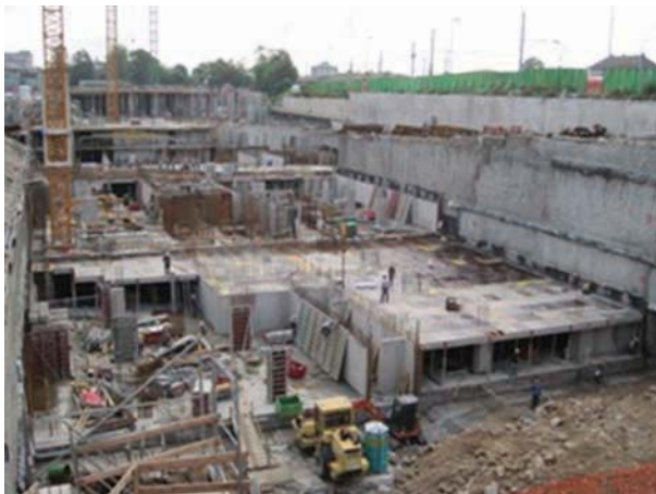
Slika 6: Primer gradbenih aktivnosti na srednje velikem gradbišču
