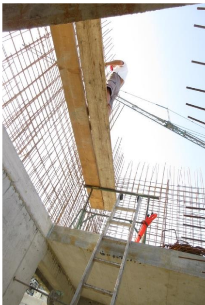
Slika 11: Neustrezna zaščita pred padcem z višine.
