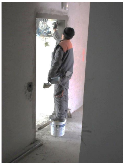
Slika 10: Neustrezno urejeno delovno mesto – improviziranje na gradbišču 1 in 2.
