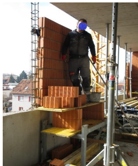
Slika 10: Neustrezno urejeno delovno mesto – improviziranje na gradbišču
