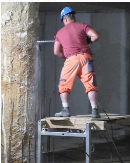
Slika 9: Neustrezno urejeno delovno mesto – improviziranje na gradbišču
