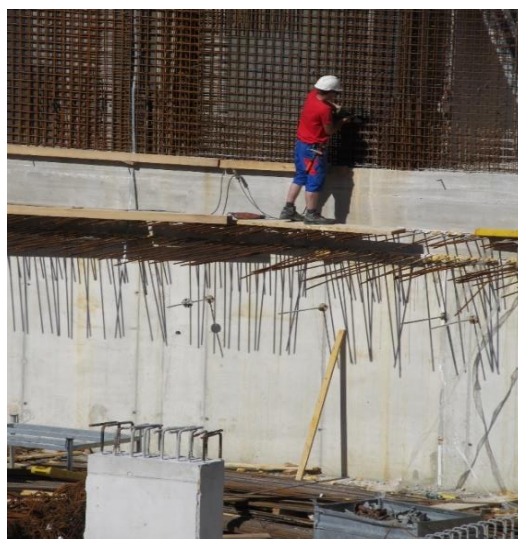
Slika 12: Nevarno izvajanje dela na višini
