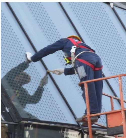
Slika 11: Nevarno izvajanje dela na višini
