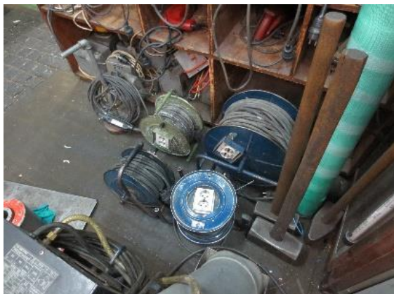
Slika 5: Neustrezni podaljševalni kabli
