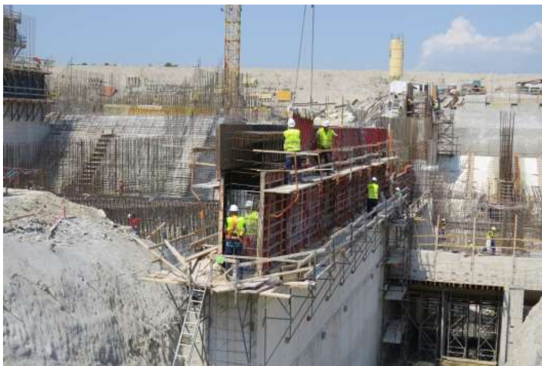
Slika 7: Strokovna ekskurzija – Izgradnja jezovne zgradbe HE Brežice», 2015 (3)
