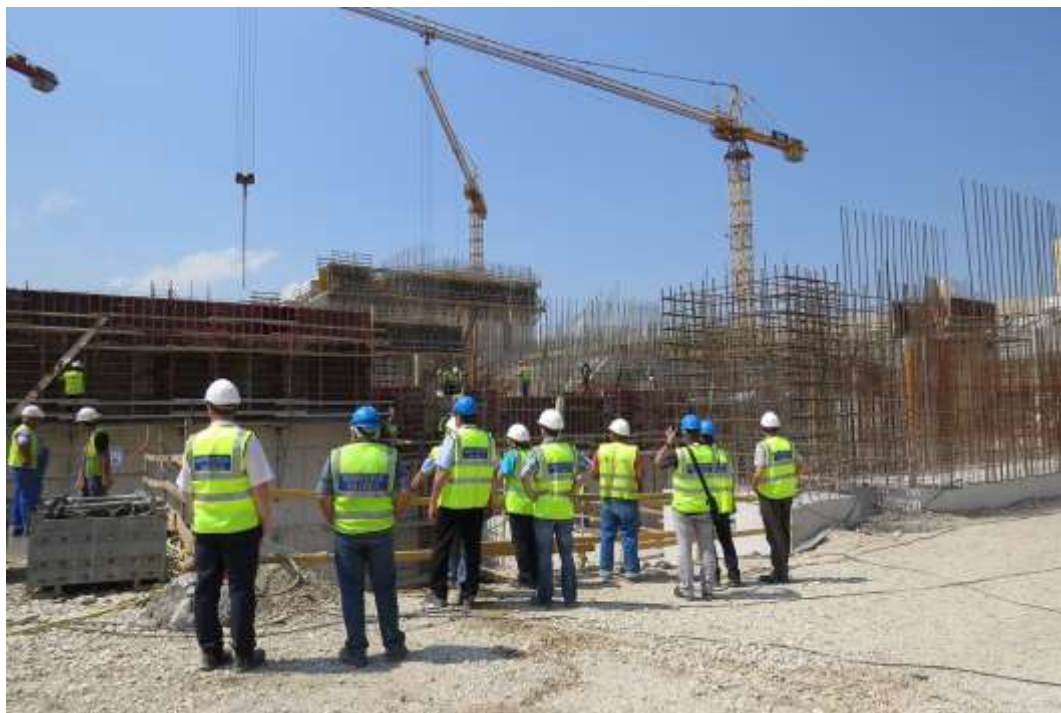
Slika 3: Strokovna ekskurzija – Izgradnja jezovne zgradbe HE Brežice«, 2015 (1)
