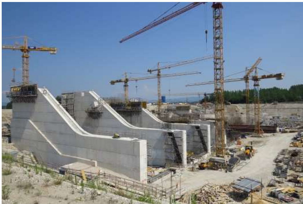
Slika 4: Strokovna ekskurzija – Izgradnja jezovne zgradbe HE Brežice», 2015 (2)
