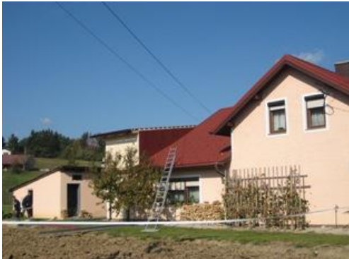
Slika 5: Neizolirani vodniki daljnovoda nad hišo so preteča nevarnost, na katero krovci ne smejo pozabiti, so vzrok smrti enega delavca v letu 2011, IRSD
