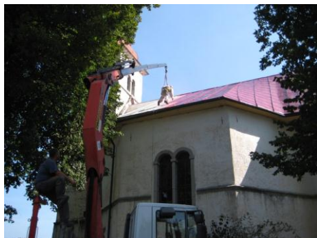
Slika 2: Brez inovacij tudi v gradbeništvu ne gre, 2011
