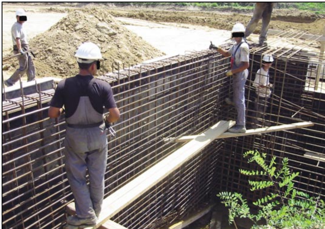
Slika 22. Značilen primer nevarne improvizacije.
