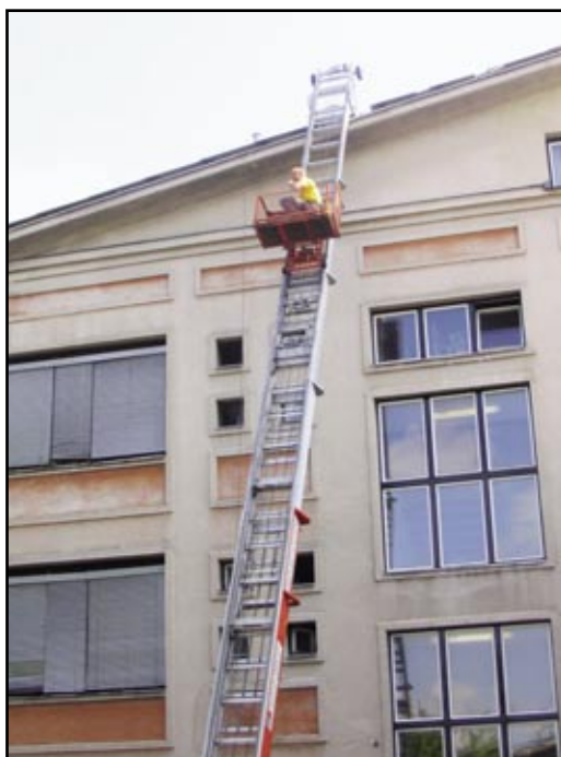
Slika 26. Oprema, ki je namenjena samo prevozu gradbenega materiala. Vendar, če je že tukaj...
