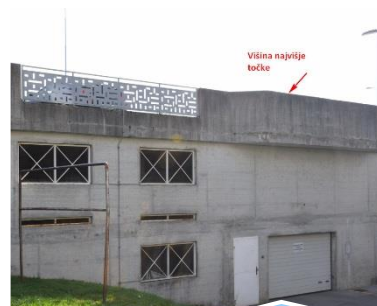
najvišja višinska kota rob zidane ograje terase
