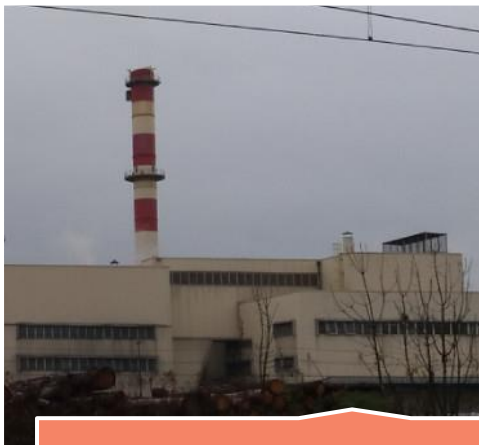
del stavbe za industrijsko rabo
