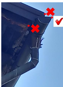
Slika 7: Vključitev žlebov v tloris stavbe.
