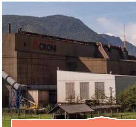
del stavbe za težko industrijo
