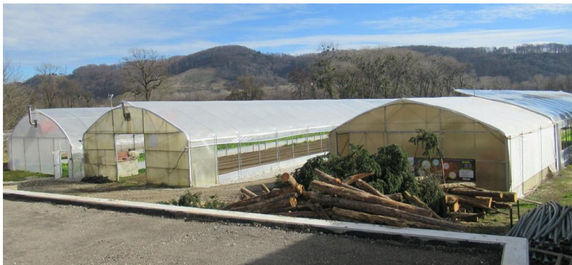
Slika 38: Primeri premičnih montažnih rastlinjakov, ki se jih po nekaj letih razstavi in prestavi na drugo lokacijo
