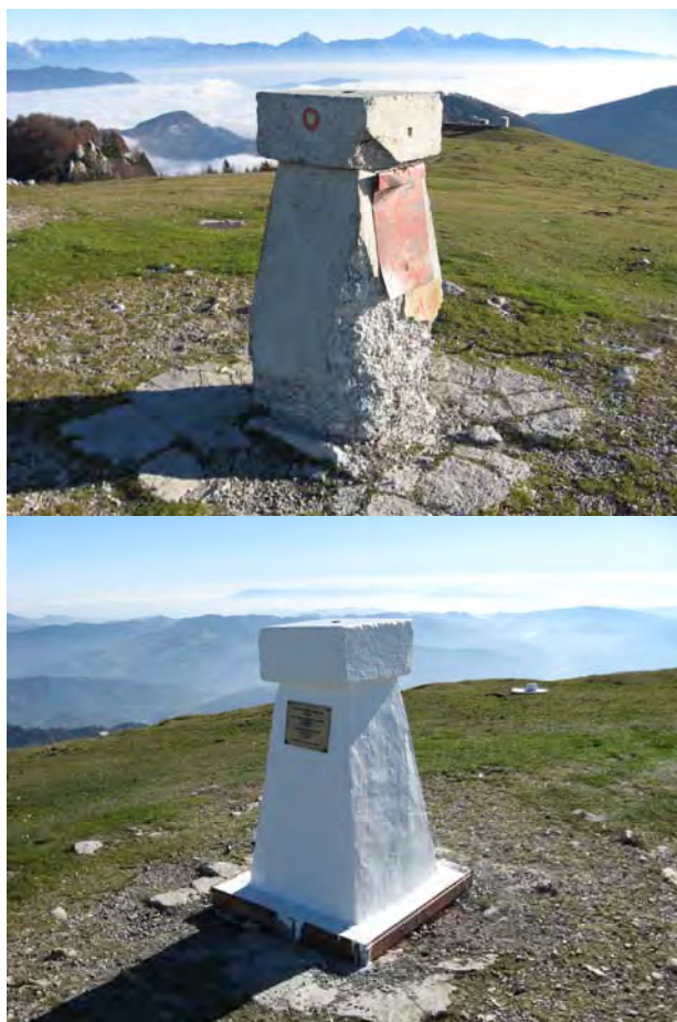
Slika 24: TT 169 – Blegoš (pred in po obnovi trigonometrične točke)
