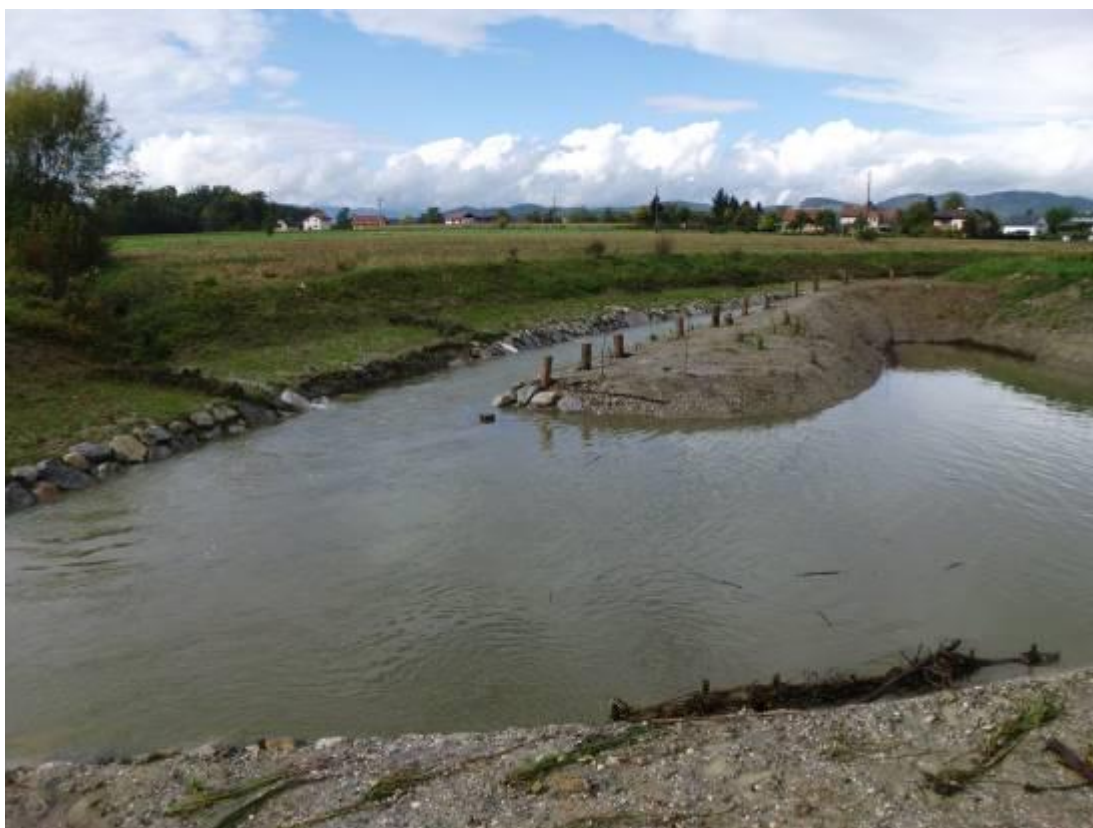
Slika 17: Primer izvedbe nadomestnega habitata - zaton (Sušnica; dolvodni pogled).
