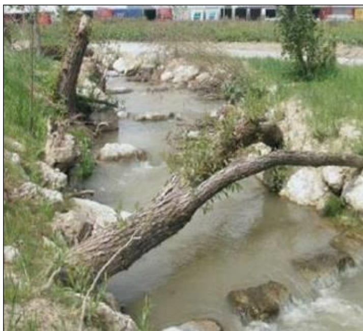
Slika 1: Primer izvedbe izrazito nepravilnih utrjenih brežin s skalami samicami in kamni (privzeto iz Grundlagen für einen österreichischen Leitfaden zum Bau von Fischaufstiegshilfen (FAHs). Bundesministerium für Land- und Forstwirtschaft, Umwelt und Wasserwirtschaft, Wien, 2011).
