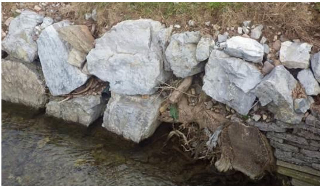
Slika 14: Prikaz za ribe ustreznega načina utrjevanja brežine - nezapolnjene luknje in špranje, ki ribam služijo kot skrivališča. Razmik med kamni oz. skalami ni zalit z betonom. Pri tem opozarjamo, da sliko prikazujemo samo zaradi prikaza ustreznega razmika med posameznimi skalami, neustrezna pa je izrazita poravnost površine utrditve, ki bi morala biti bolj hrapava oz. neporavnana.
