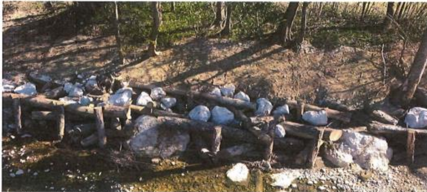
Slika 1: Prikaz utrditve brežine z leseno, neporavnano kašo, napolnjeno s kamenjem (vir: ZZRS, 2022).
