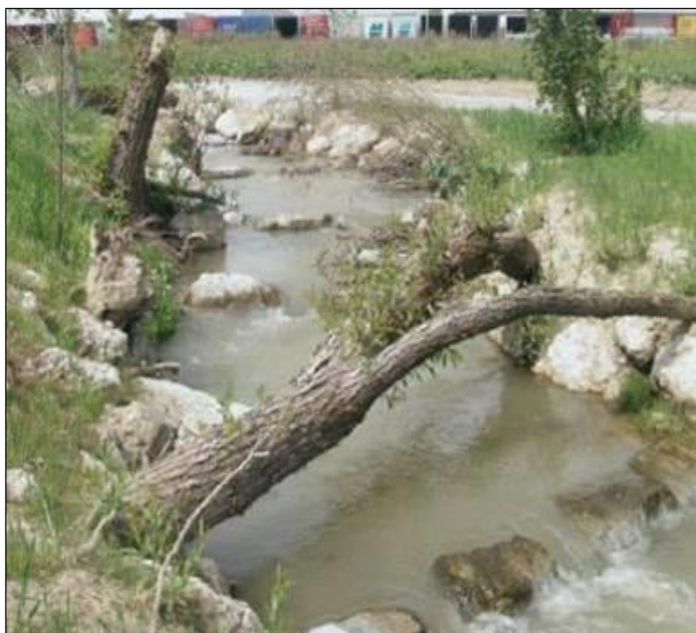
Slika 1: Primer izvedbe izrazito neporavnanih utrjenih brežin s skalami samicami in kamni (privzeto iz Grundlagen für einen österreichischen Leitfaden zum Bau von Fischaufstiegshilfen (FAHs). Bundesministerium für Land- und Forstwirtschaft, Umwelt und Wasserwirtschaft, Wien, 2011).
