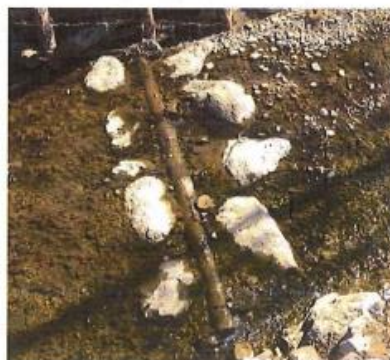
Slika 2: Prikaz utrditve enostopenjskega lesenega pragu (vir: ZZRS, 2022).
