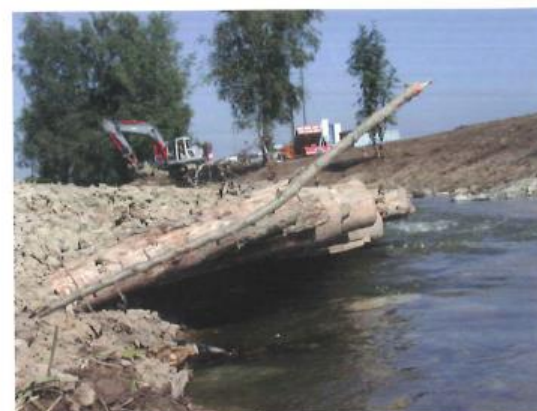
Slika 5: Možnosti za izvedbo sonaravno oblikovanih skrivališč za ribe ob brežinah [str. 1 od 2] (privzeto iz Entwicklung naturnaher Bäche und Flüsse , Gebler 2005).
