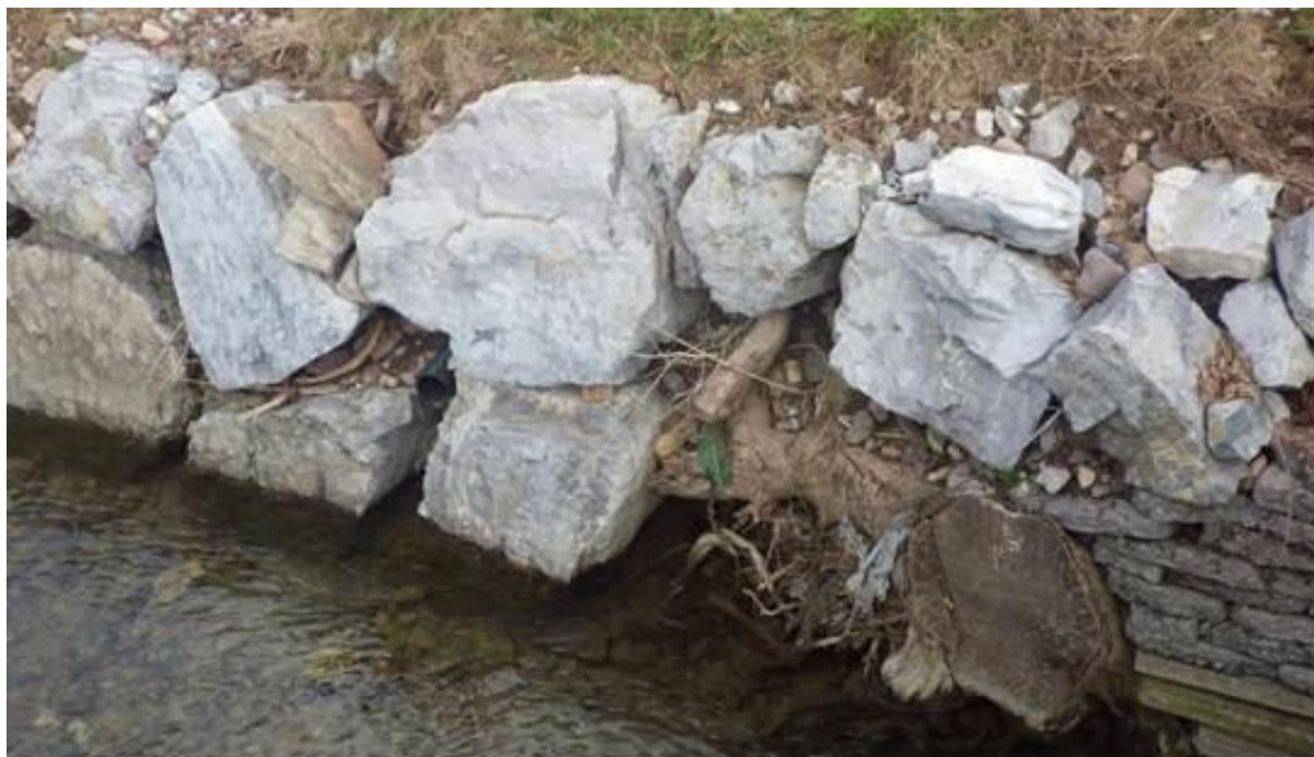
Slika 64: Prikaz za ribe ustreznega načina utrjevanja brežine - nezapolnjene luknje in špranje, ki ribam služijo kot skrivališča. Razmik med kamni oz. skalami ni zalit z betonom. Pri tem opozarjamo, da sliko prikazujemo samo zaradi prikaza ustreznega razmika med posameznimi skalami, neustrezna pa je izrazita poravnost površine utrditve, ki bi morala biti bolj hrapava oz. nepravilna.
