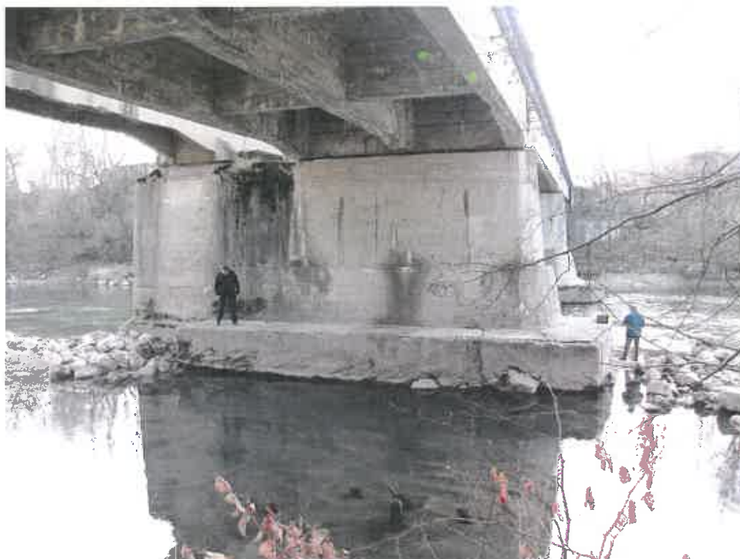
Pogled z leve obale na levo obrežni rečni steber, kjer je dobetoniran temelj sedaj dodatni balast
