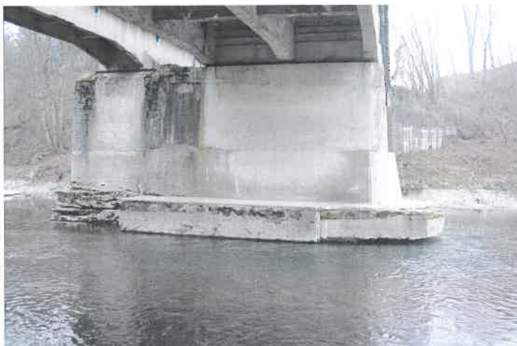
Pogled na desno obrežni rečni steber z temelja levo obrežnega rečnega stebra
