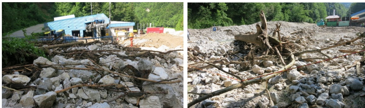
Slika 9. Akumulacija materiala (blokovni grušč, debla, korenine) nad spodnjo postajo žičnice (levo) in pod postajo žičnice (desno) po hudourniškem dogodku 30.5.2018 (foto: GeoZS, 2018).
