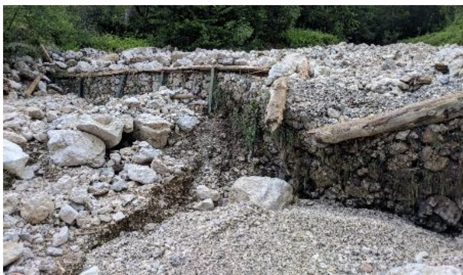
Slika 4. Uničen sistem pragov na Brezovškem grabnu.
