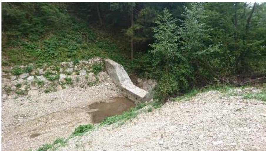
Slika 3. Obstoječa zaplavna pregrada v P44.
