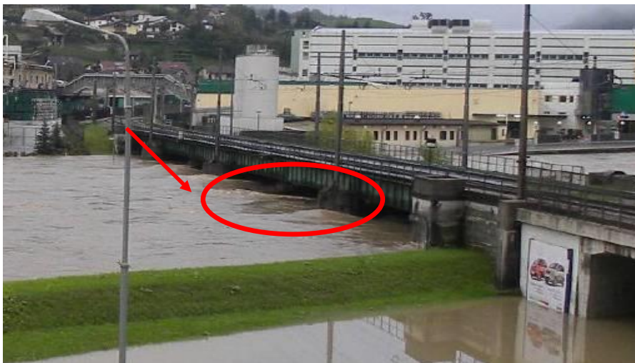
Slika 7: Vpliv mostnih opornikov železniškega mostu.
