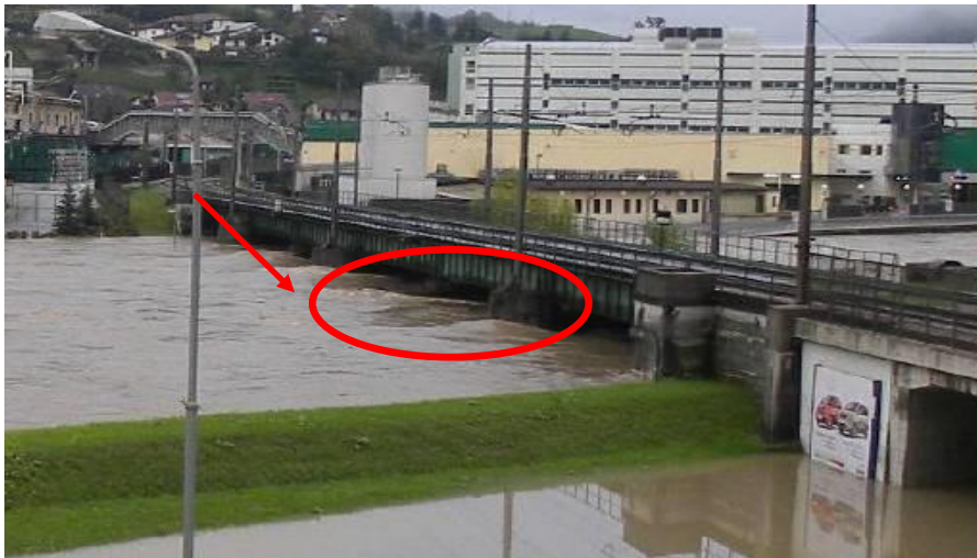
Slika 7: Vpliv mostnih opornikov železniškega mostu.
