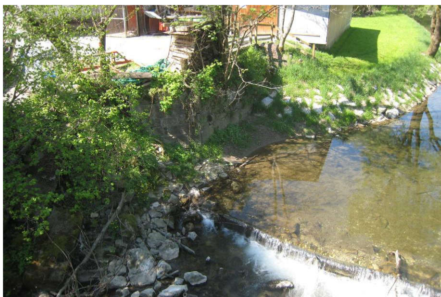
Slika 11: Ostanke mostnega opornika –obstoječi zid se podbetonira
