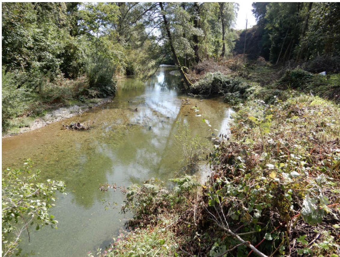
Slika 6: Zajeda na območju med P90_1 in P90. Predvidena je sanacija (zasip in utrditve).
