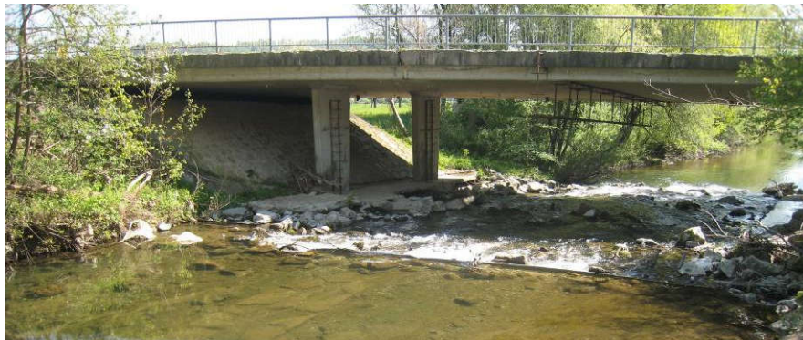
Slika 11: Ostanke mostnega opornika –obstoječi zid se podbetonira
