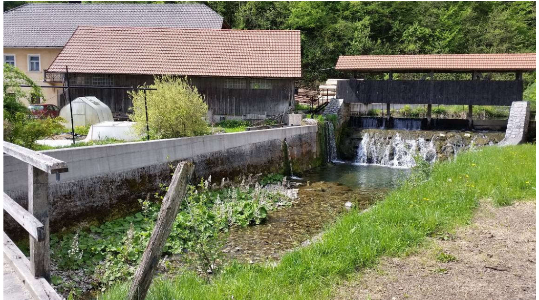
Slika 11: Nadgrajeni obrežni zidovi na območju nad mostom se obložijo z montažnimi AB ploščami.
