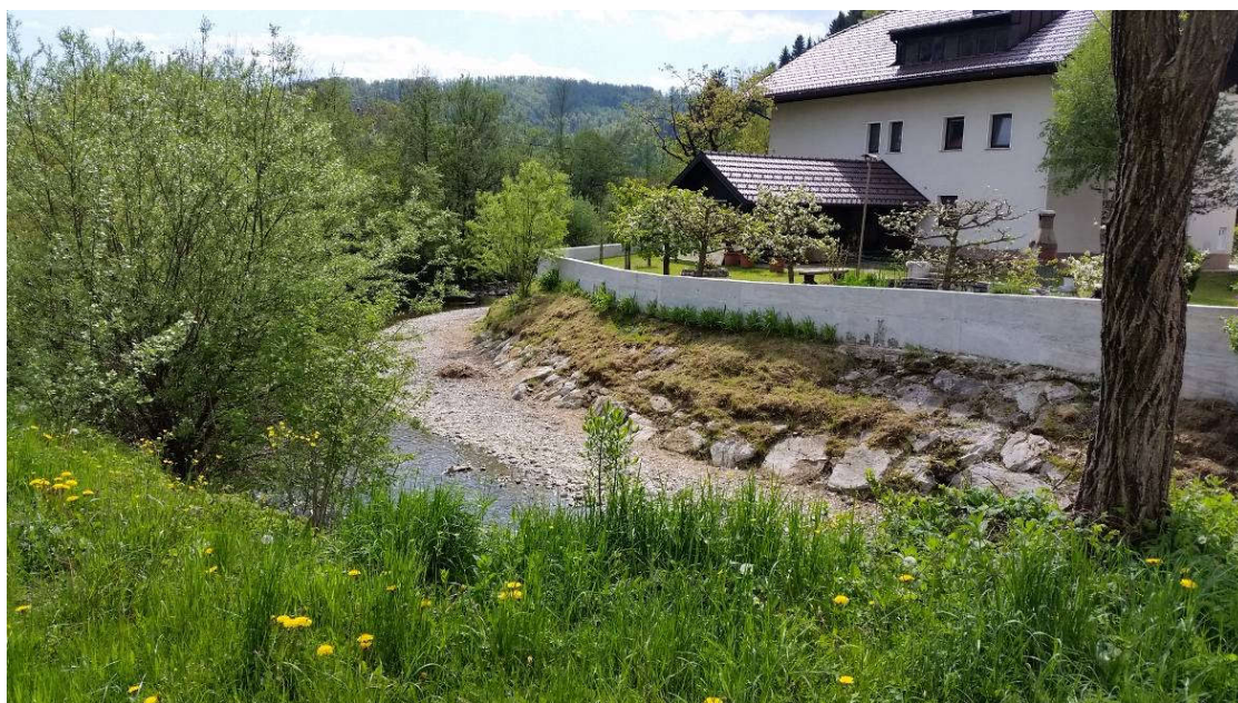
Slika 12: Novozgrajeni zid se obloži s kamnito oblogo in nadviša do projektirane kote
