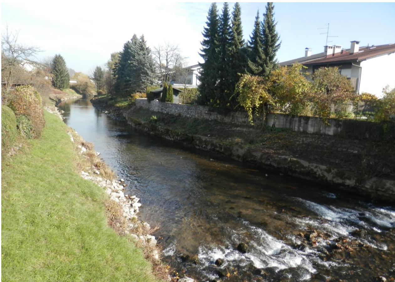
Slika 8: Obstoječi visokovodni zidovi in obrežne utrditve ob desni brežini pod mostom na Opekarski cesti.
