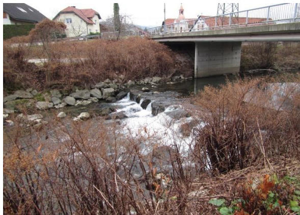
Slika 70: Za ribe težko prehoden prečni objekt pod mostom na Cesti dolomitskega odreda (december, 2016)
