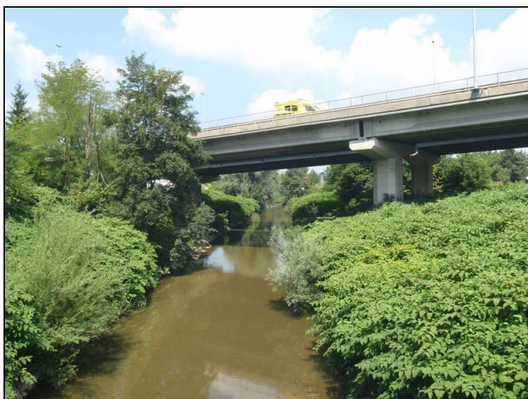
Slika 29: Rastišče tujerodnega dresnika pod AC na Dolgem mostu (avgust 2015)
