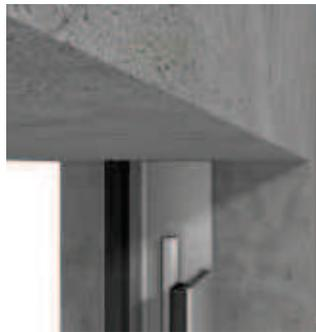
**33** Das schräge Einfädeln der Damm balkens vereinfacht die Montage (Montagehilfe Silikonspray oder Gleichwertiges).
