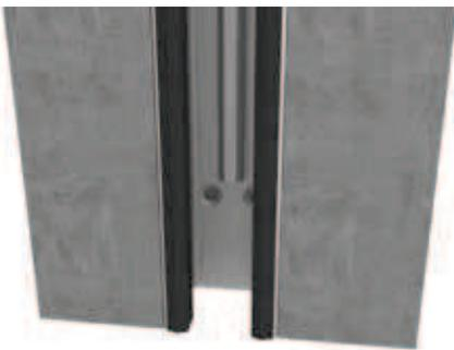
**21** Ist ein Einfädeln der Dämmbalken an der Oberseite des U-Profils nicht möglich (z. B. Türstock usw.), ist ein ausreichender Überstand der seitlichen Mauerschlitze zu berücksichtigen (wird von der Firma PREFA ermittelt).
