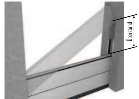
**23** Es ist darauf zu achten, dass die Dämmbalken mittig positioniert werden, sodass auf beiden Seiten der Abstand gleich ist.
