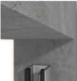
**32** Zum Einfädeln des obersten Damm balkens ist eine Ausfräsung im Seitenteil des Damm balkens vorzusehen.
