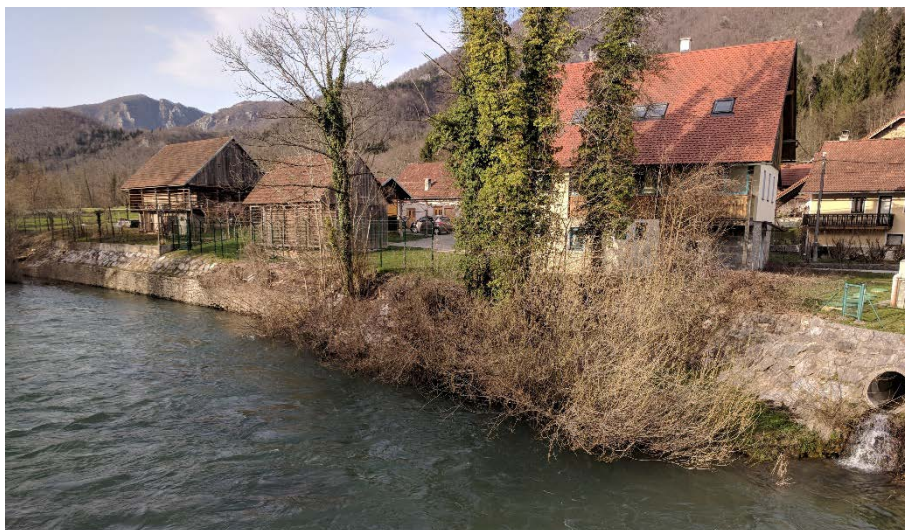
Slika 2. Leva brežina Kolpe gorvodno od mostu, pogled gorvodno.
