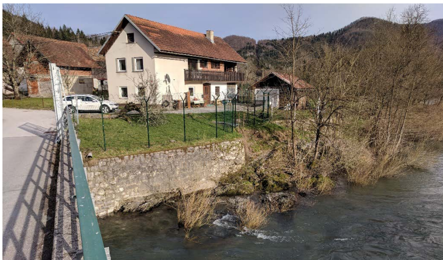
Slika 4. Ureditev dolvodno od mostu.
