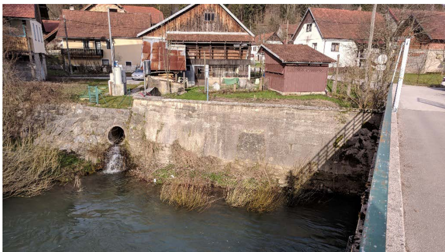
Slika 3. Betonski zid tik gorvodno od zidu, iztok meteornega kanala.
