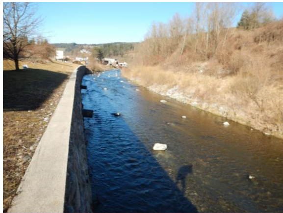
Slika 2: Primer neustrezne umestitve skal.
