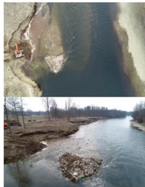
Izdelava skalne strukture
