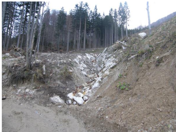
Ureditev odvodnje in površine plazišča
