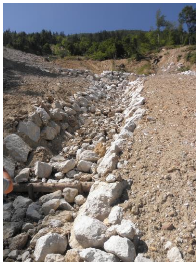
Ureditev odvodnje in površine plazišča
