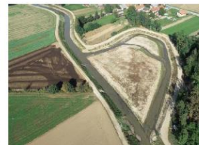
Obnova naravnega poteka struge Polškave z ohranitvijo regulirane struge (projekt Dravinja s Polškavo) (DRSV, 2024)
