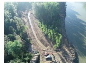
Obnova rokava Dokležovje I na Muni (izkop in obnova vtoka) za vzpostavitev naravne rečne dinamike in izboljšanje stanja habitatov (Rokavica, DRSV, 2023)
