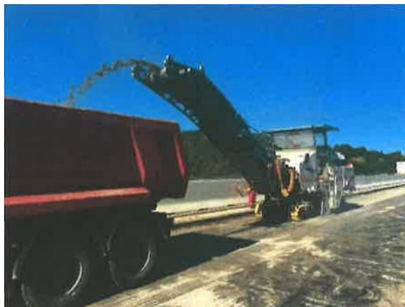
Slika 8.2: Priprava betonske površine c)
