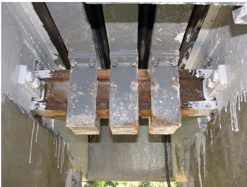
Slika 13.31: Resne poškodbe drsnega sistema lamelne dilatacije zaradi vodonetesnosti tesnilnih trakov
