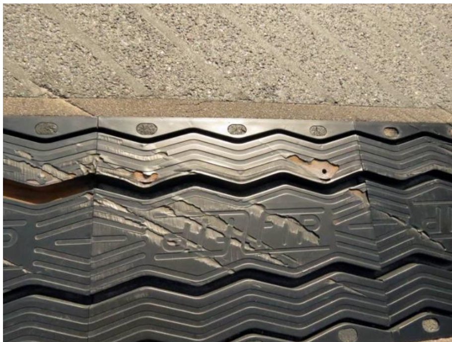
Slika 13.12: Posledice rezila snežnega pluga spuščenega do ravnine dilatacije – pluženje na »črno« - začetne poškodbe na blazinasti dilataciji
