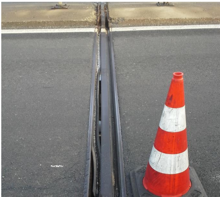
Slika 13.30: Iztaknjen tesnilni trak iz rege lamelne dilatacije
