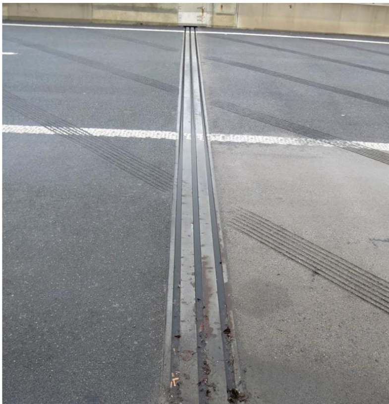
Slika 13.26: Zastajanje vode v regah lamelne dilatacije - dopolnilno izvedeno površinsko dreniranje meteorne vode s cestišča z rebričenjem, zaradi premajhnega prečnega sklona in ker cevke za proniciujočo vodo mogoče ne delujejo zaradi zasiganosti
