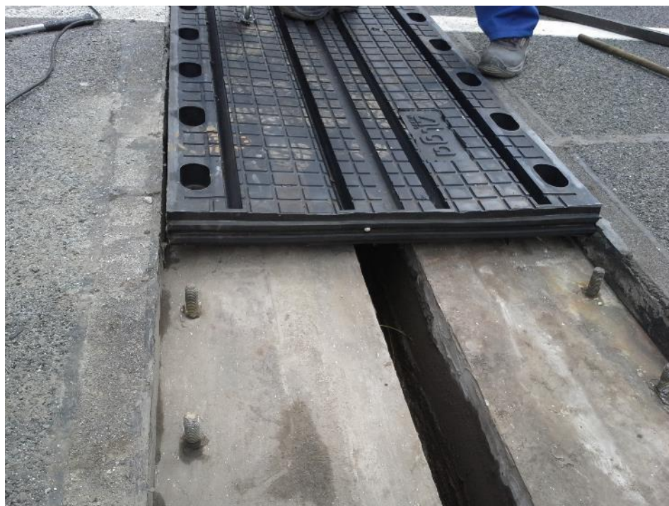
Slika 13.29: Stik blazinastega segmenta dilatacije – pogojna vodotesnost
