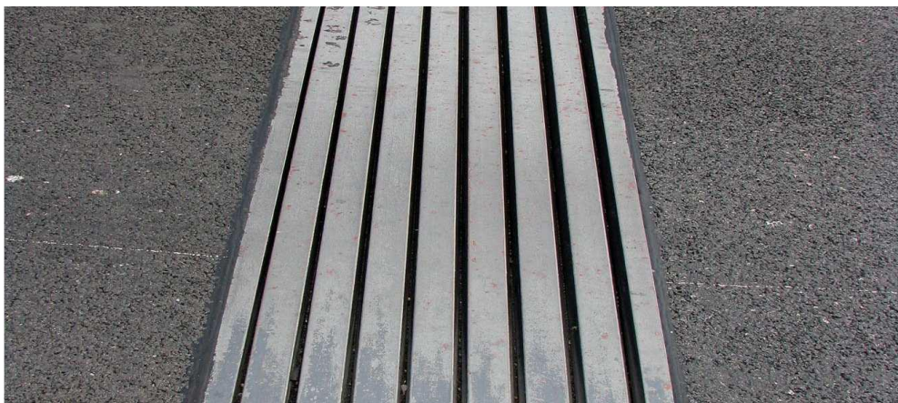
Slika 13.3: Primer neustrezne zasnove krmilnega sistema gredne lamelne dilatacije – neenakomerne širine reg vmesnih lamel
