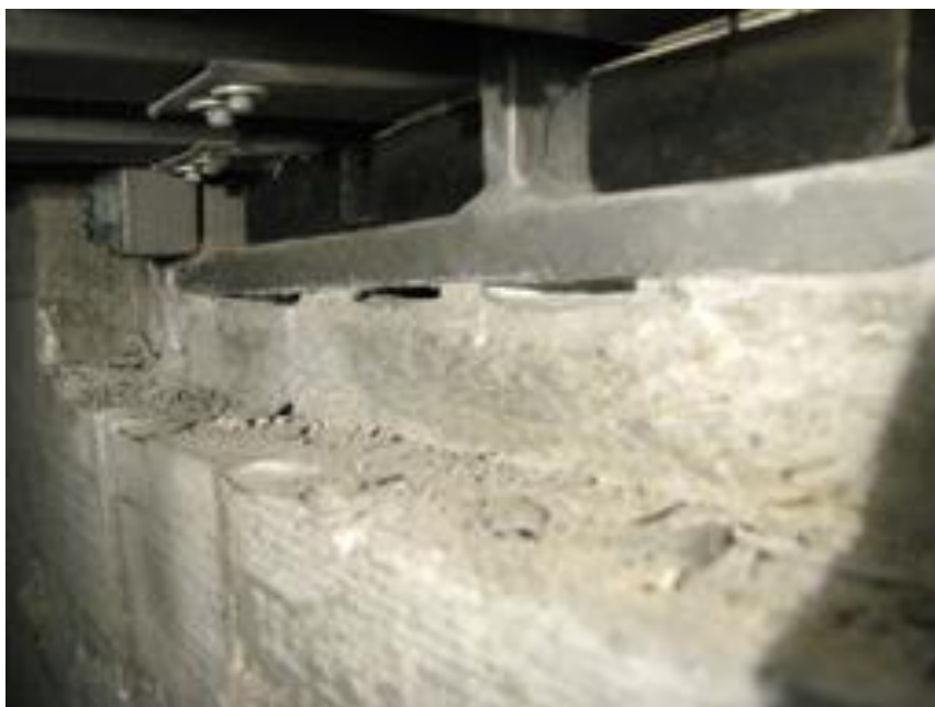
Slika 13.8: Primer škatle krmilnega sistema (grednega) lamelne dilatacije – porozna mesta betona pod škatlo
