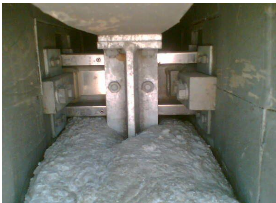
Slika 13.10: Primer prodora betona v škatlo zaradi popuščanja opaža – z betonom oblito streme z drsnimi ležišči ne more delovati
