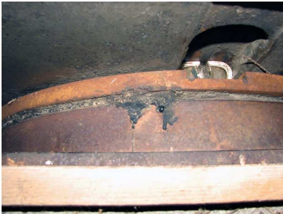
Slika 83: Iztiskanje teflonskega diska iz batnice v utor vzdolžnega vodila lončnega ležišča. Iztiskanje elastomerne blazine iz lonca.
