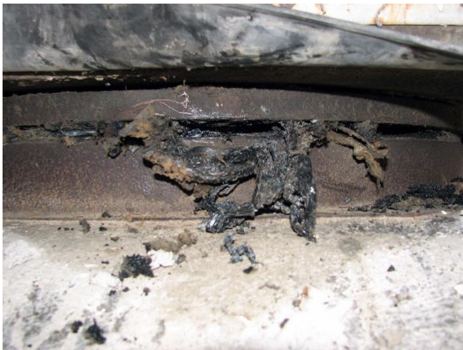
Slika 84: Iztiskanje elastomerne blazine iz lonca lončnega ležišča.
