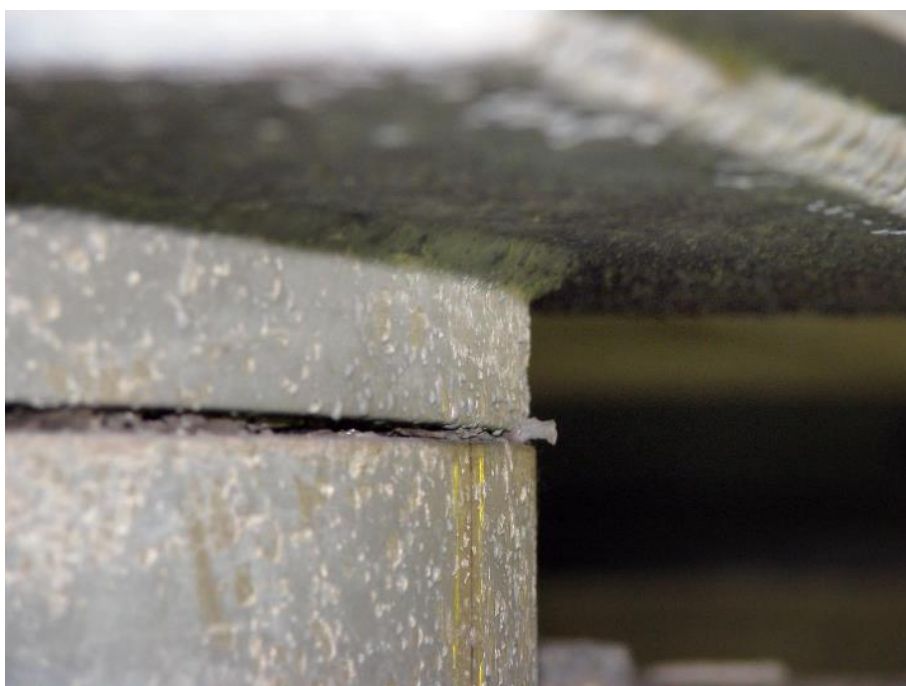
Slika 110: Premajhen razmik nagibne špranje med loncem in batnico lončnega ležišča.
