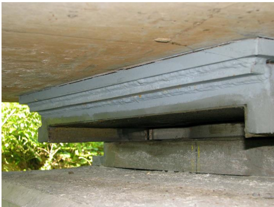
Slika 107: Nepodliti stik med loncem in betonskim podstavkom.
