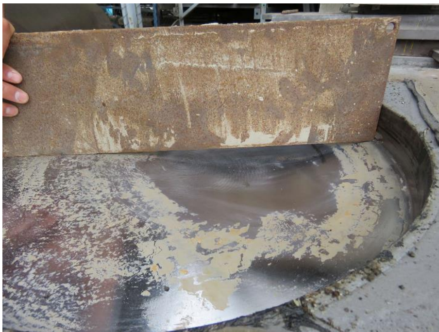
Slika 133: Deformacija lonca lončnega ležišča zaradi napake pri podlivanju.
