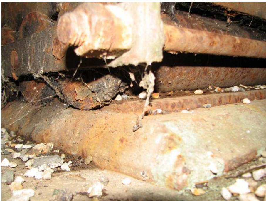
Slika 147: Več valjčno ležišče – nečista kotalna površina.
