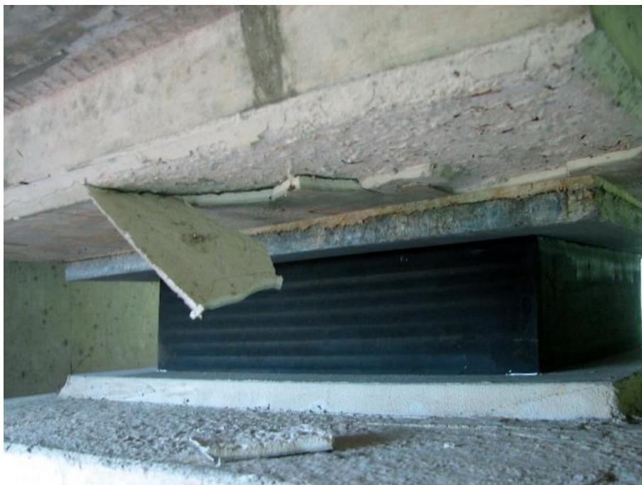
Slika 51: Nekvalitetno izveden zgornji ležiščni blok.
