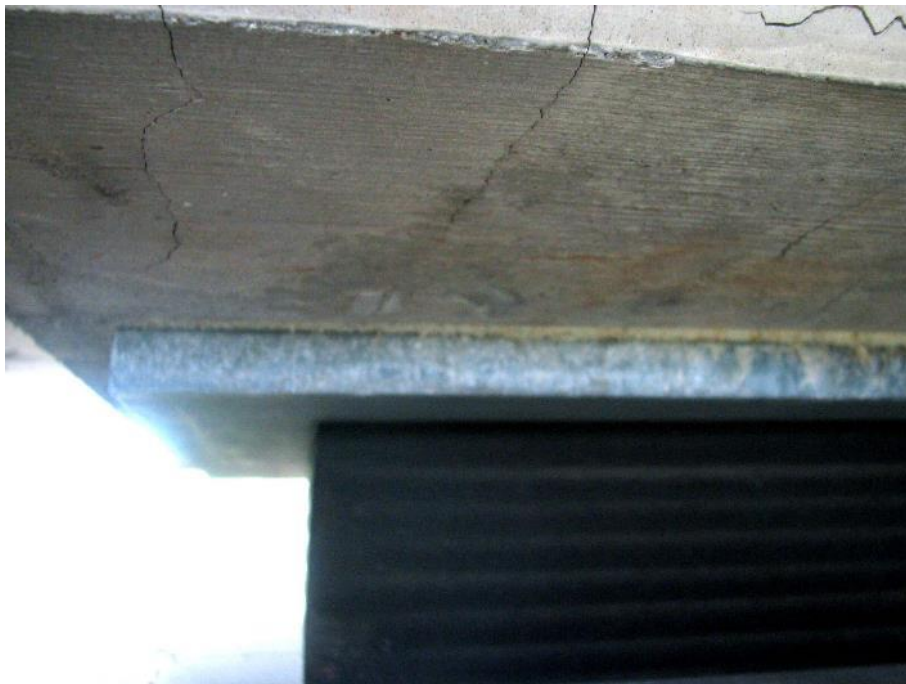
Slika 41: Razpoke v zgornji ležiščni blazini.
