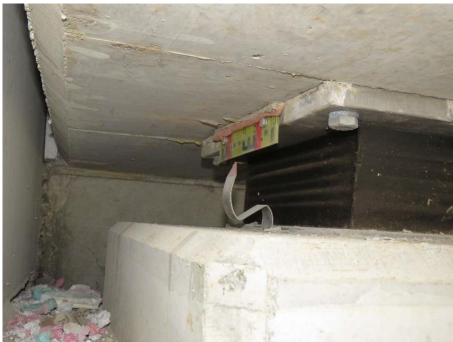
Slika 137: Deformiran kazalec pomikov.
