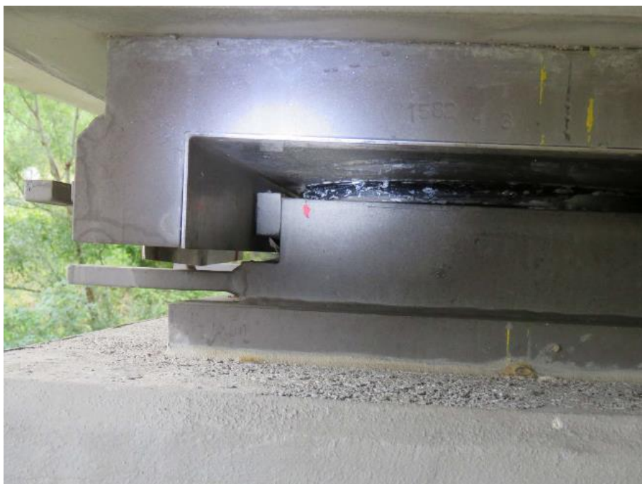
Slika 140: Iztiskanje MSM drsnega diska sfernega ležišča iz nosilnega ohišja.
