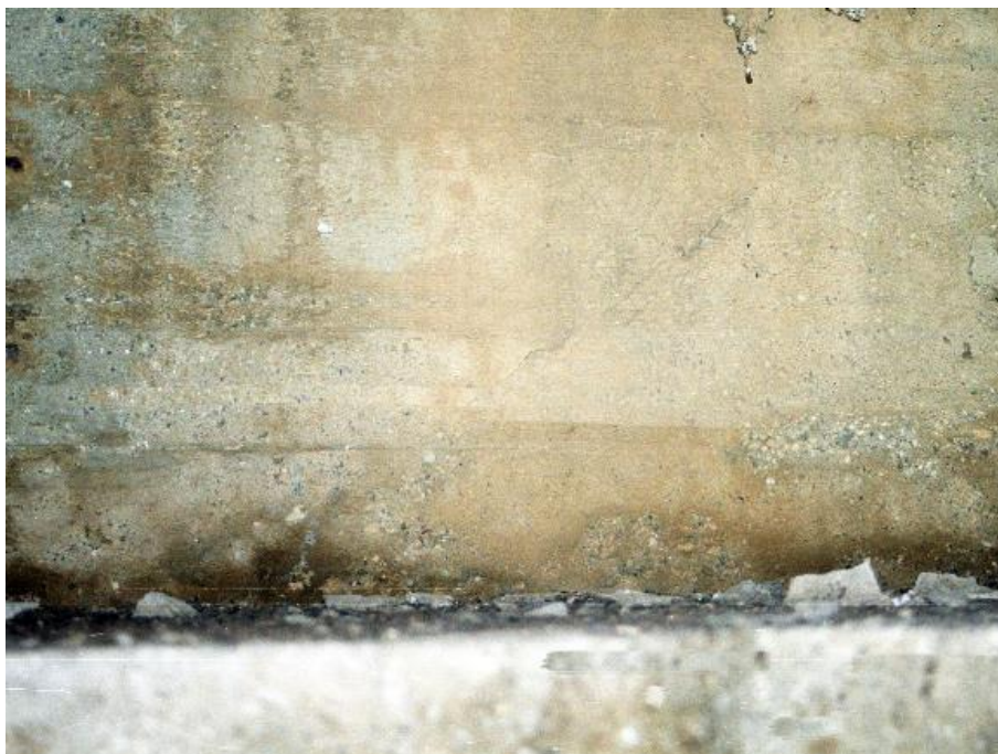
Slika 152: Betonsko valjčno ležišče – strižna razpoka.
