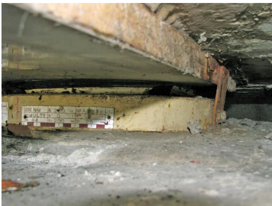
Slika 104: Iztiskanje elastomerne blazine iz lonca lončnega ležišča.
