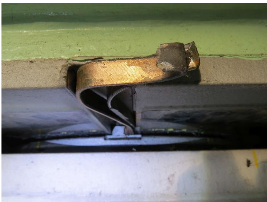
Slika 130: Iztiskanje bočnega drsnega traku in nerjavne pločevine centralnega vodila lončnega ležišča.
