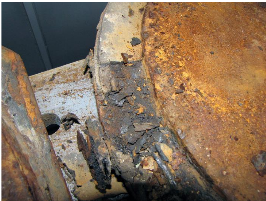
Slika 96: Korozijske poškodbe batnice - detajl.
