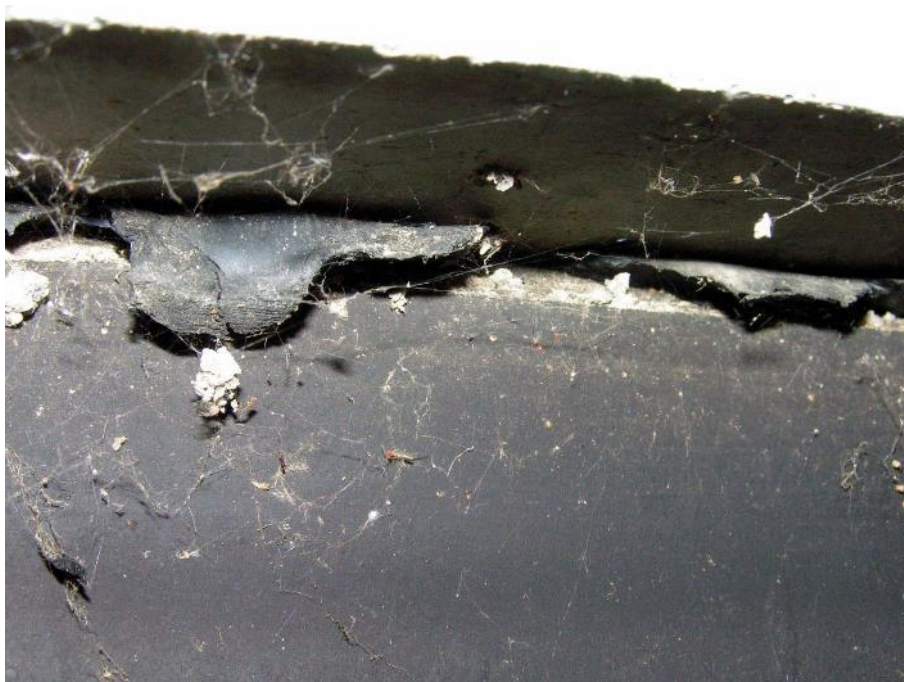
Slika 37: Struženje elastomerja zgornjega krovnega sloja zaradi zdrsavanja po kontaktu elastomernega bloka z zgornjo ležiščno blazino. V robu stika je tanek sloj epoksidne malte, ki naj bi zapiral stik po obodu med ležiščem in ležiščno blazino.
