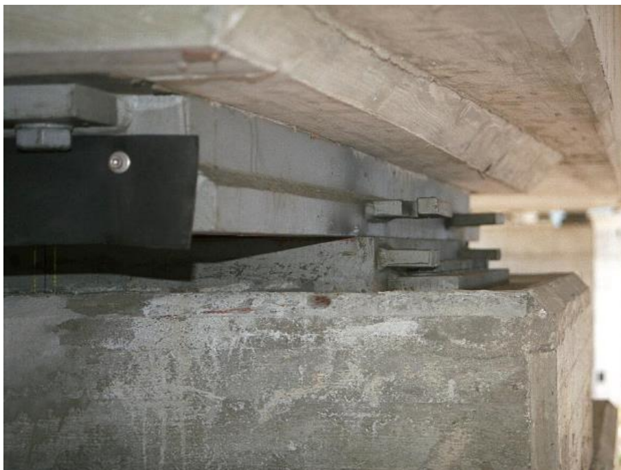
Slika 101: Bočno vodilo lončnega ležišča nasedlo na lonec zaradi neustreznega podlitja ležišča.
