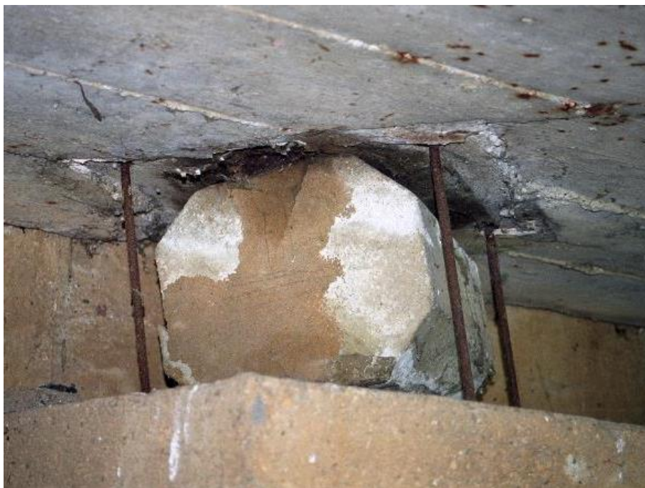
Slika 150: Betonsko valjčno ležišče.
