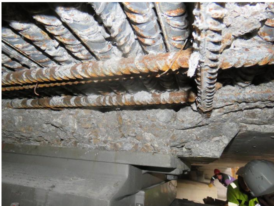
Slika 139: Gosta armatura prečnika ob in nad ležiščem.
