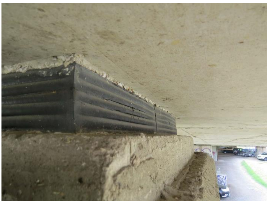
Slika 18: Razpoke elastomerja v nivoju jeklenih plošč.
