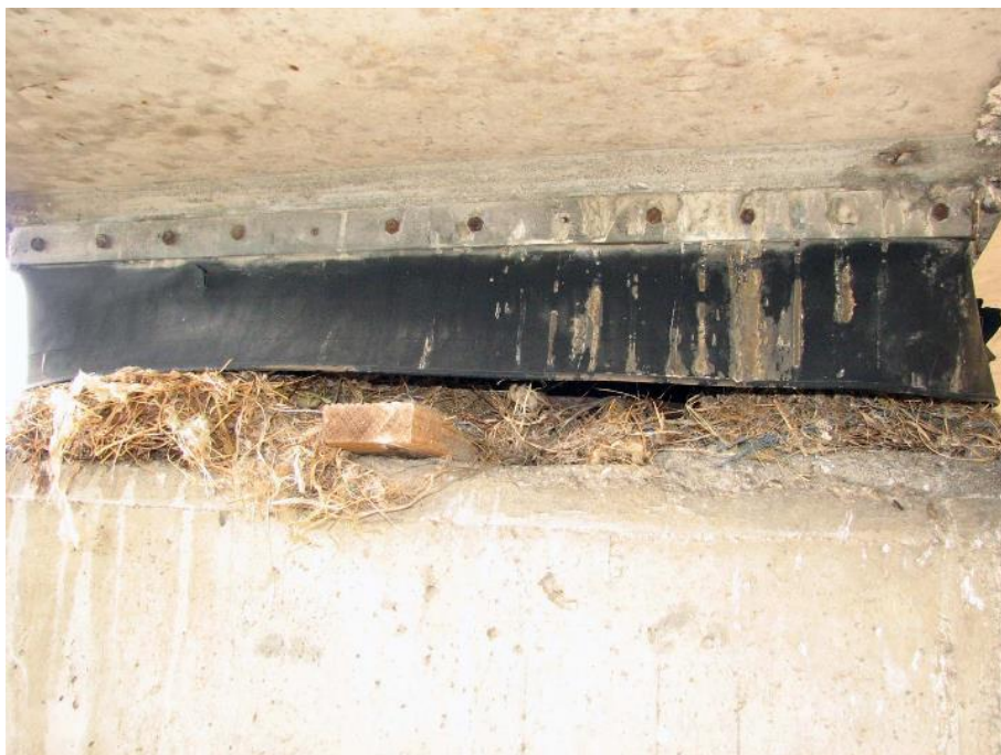
Slika 77: Ptičje gnezdo pod nezaščiteno drsno površino.
