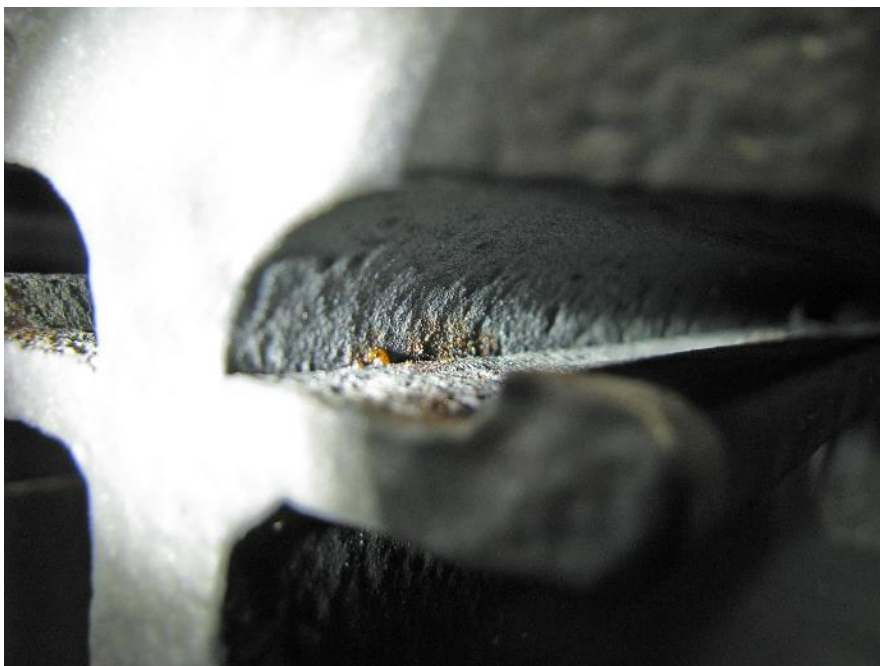
Slika 8.4: Kontrola izvedbe protikorozijske zaščite s premazi (v utoru ne sme biti razlite barve ter v celoti izveden osnovni premaz-brez ostankov korozije)
