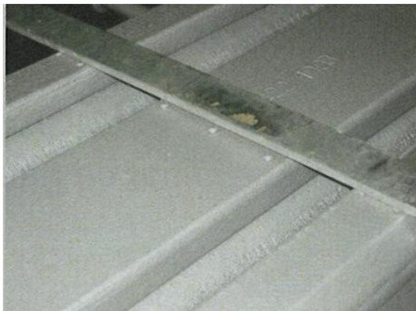
Slika 6.5: Jeklne udarne točke na zgornji površini lamel in robnih profilov v izogib strižnemu premiku pri prednastavitvi lamelne dilatacije
