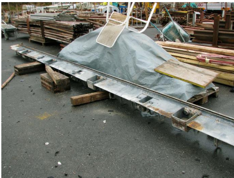
Slika 8.1: Razstavljena dilatacija na platoju v delavnici- robni profil z zabojniki
