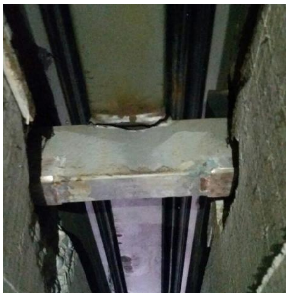
Slika 13.17: Na utrujanje nezadostno zasnovani zvari vitalnih jeklenih delov npr. zvarov med lamelami in prečkami. Znan primer so lamelne gredne jeklene dilatacije proizvajalca Maurer tipa DT proizvodnje od 1981 do 2003
