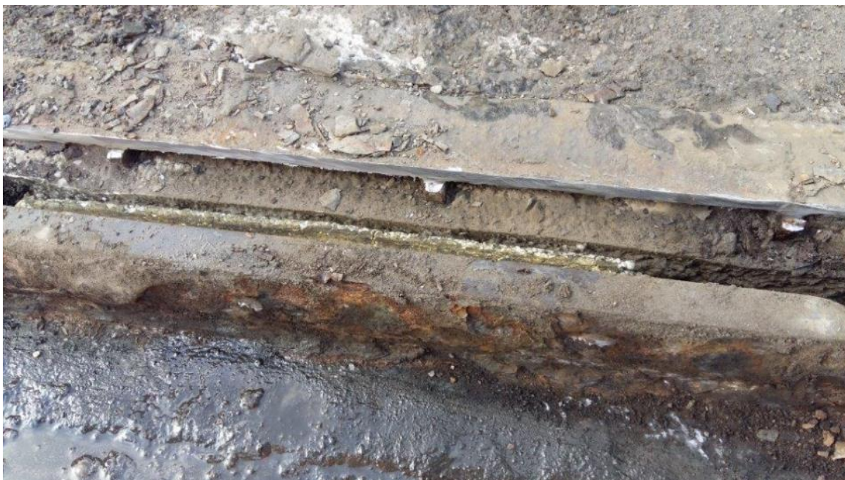
Slika 13.9: Primer nepodlitih mest pod robnim profilom (jeklina pasnica brez odprtih za odzračenje)
