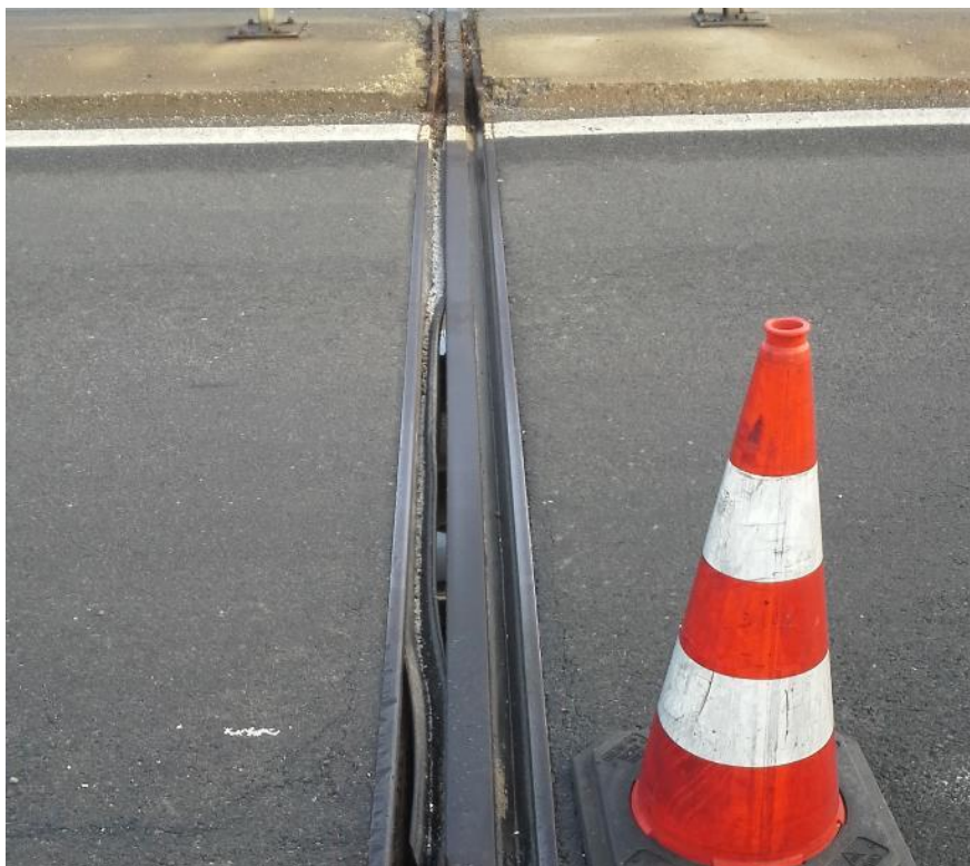
Slika 13.30: Iztaknjen tesnilni trak iz rege lamelne dilatacije
