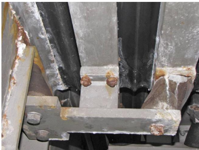
Slika 13.1: Primer posledic neustrezne (preširoke rege) prednastavitve lamelne dilatacije – krmilni mehanizem odpoveduje, netesnost stika elastomernega traku (izvlek iz utora)
