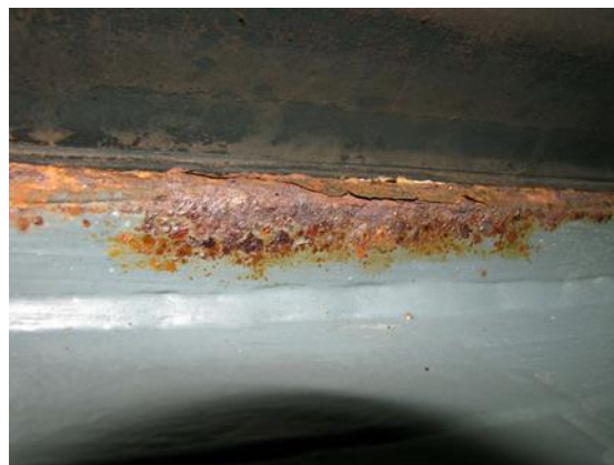
Slika 13. 28: Primer neustreznega vpetja elastomernega traku v čeljusti robnega in vmesnega profila (točkovno tesnjenje namesto linijskega tesnjenja po obodu utora), tehnična vodotesnost ni zagotovljena
