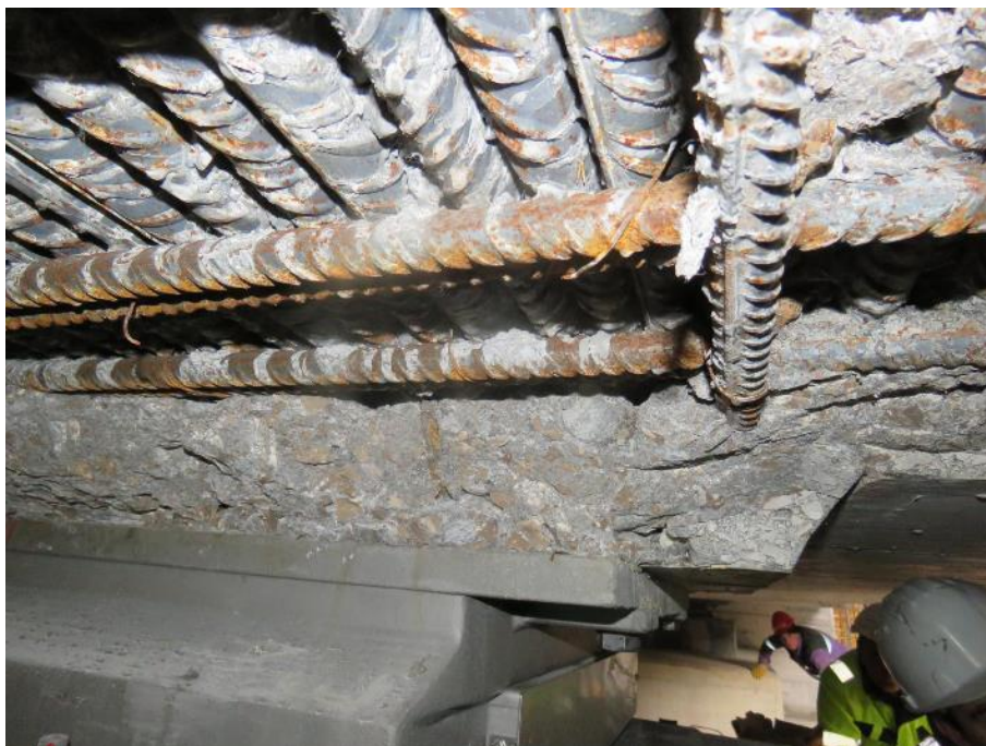
Slika 139: Gosta armatura prečnika ob in nad ležiščem.
