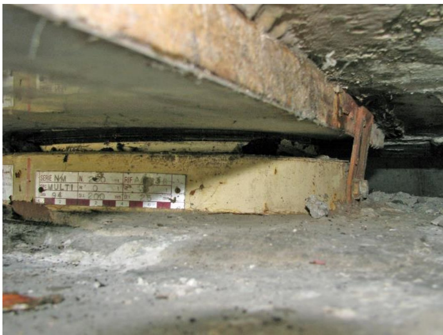
Slika 104: Iztiskanje elastomerne blazine iz lonca lončnega ležišča.
