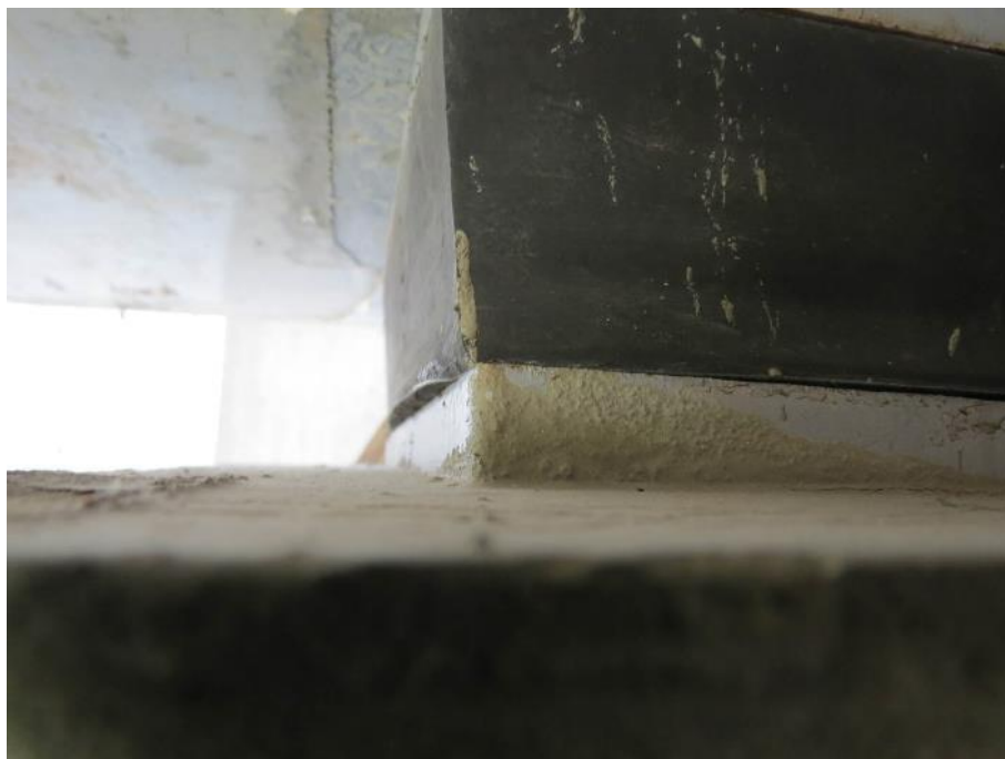
Slika 5: Iztiskanje elastomerja na robu kontakta s spodnjo ležiščno ploščo.
