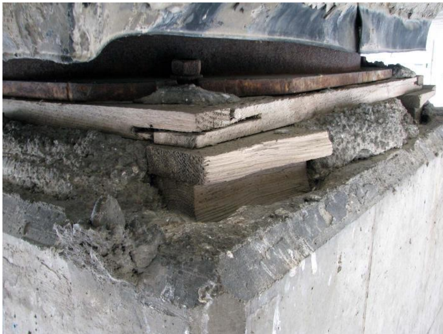
Slika 79: Neustrezno vgrajeno lončno ležišče.
