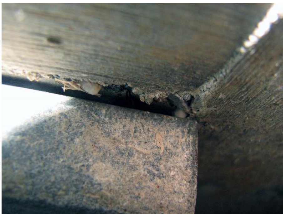
Slika 42: Zdrs zgornje ležiščne plošče deformabilnega ležišča po stiku z ležiščno blazino.
