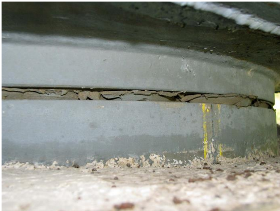
Slika 113: Propadanje tesnilnega traku nagibne reže.
