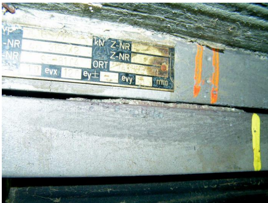
Slika 24: Betonska matrica v drsni špranji deformabilnega drsnega ležišča.
