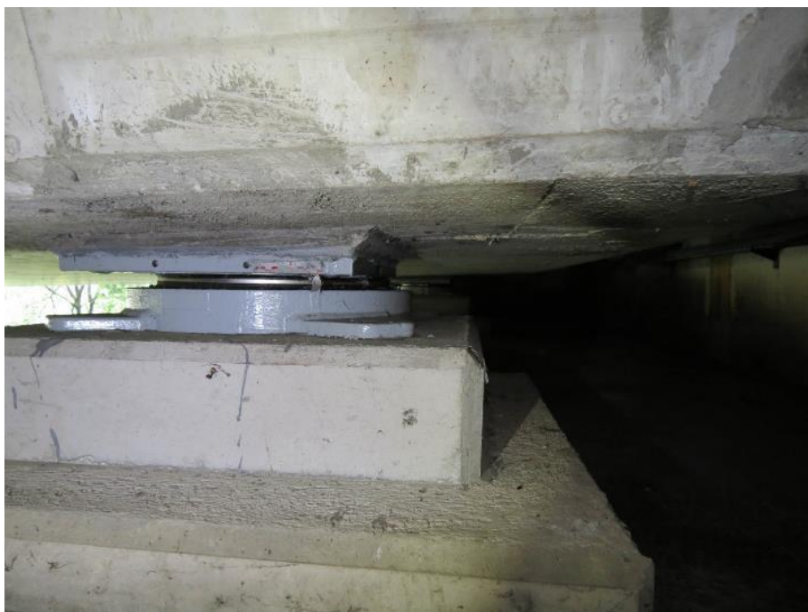
Slika 114: Prevelik pomik vodenega drsnega ležišča.
