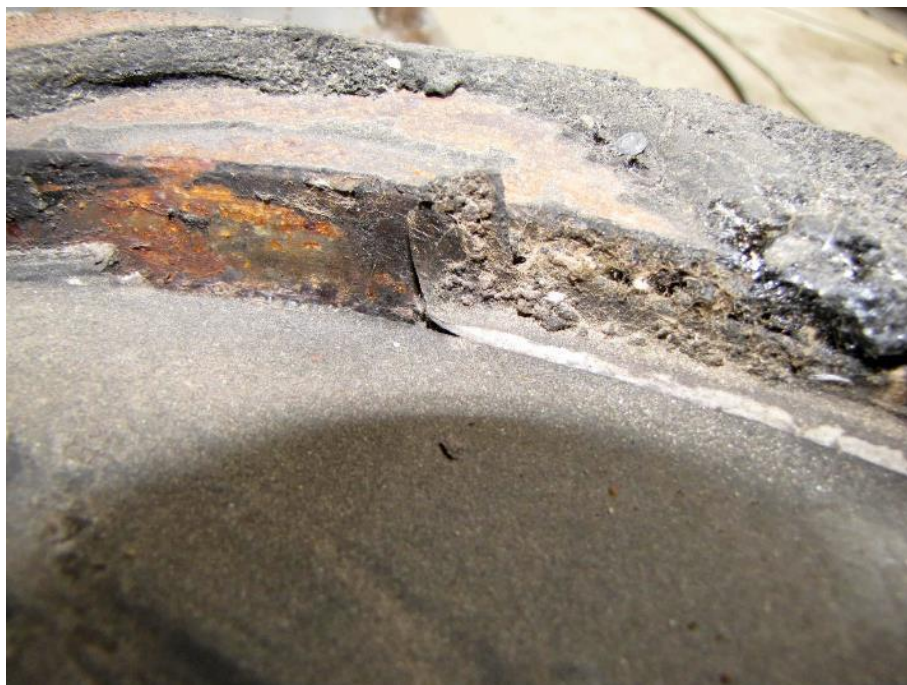
Slika 86: Lokalno mesto iztiskanja elastomerne blazine na robu lonca.
