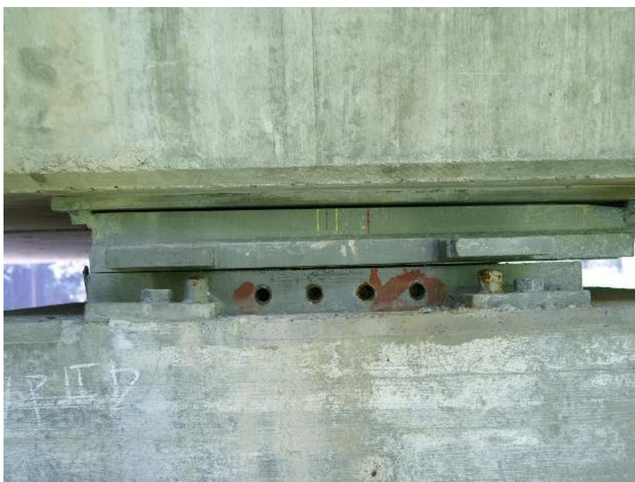
Slika 106: Kontakt bočnega vodila z loncem zaradi neustreznega podlitega ležišča.
