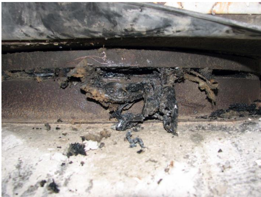
Slika 84: Iztiskanje elastomerne blazine iz lonca lončnega ležišča.
