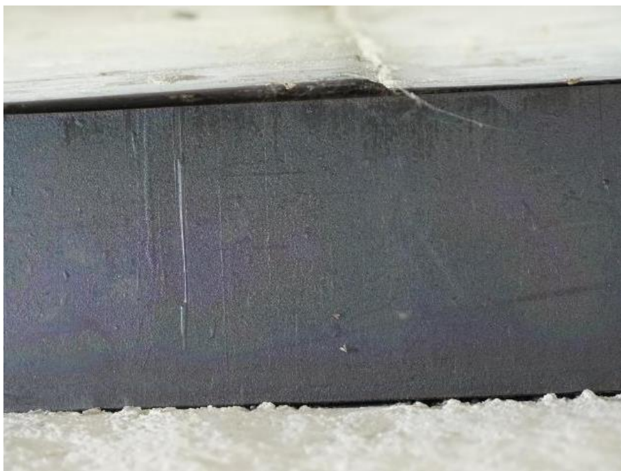
Slika 54: Neustrezno izdelana kontaktna površina plošče v področju ležišča zaradi zamaknjenih opažnih plošč. Neenakomerna obremenitev ležišča.
