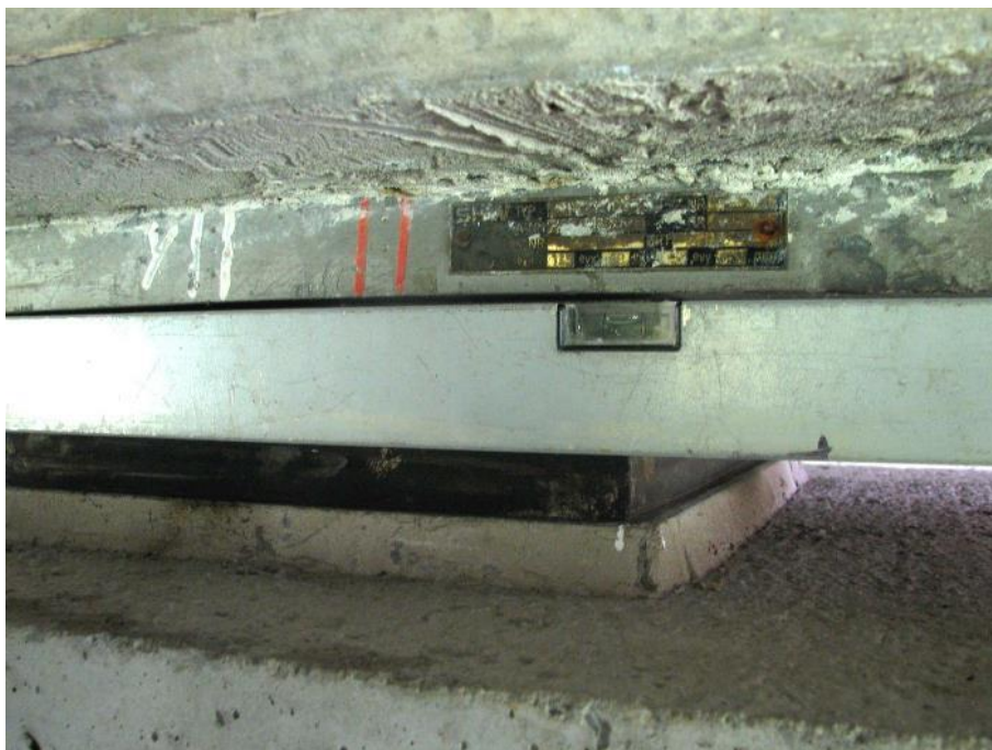
Slika 135: Deformacija drsne plošče.
