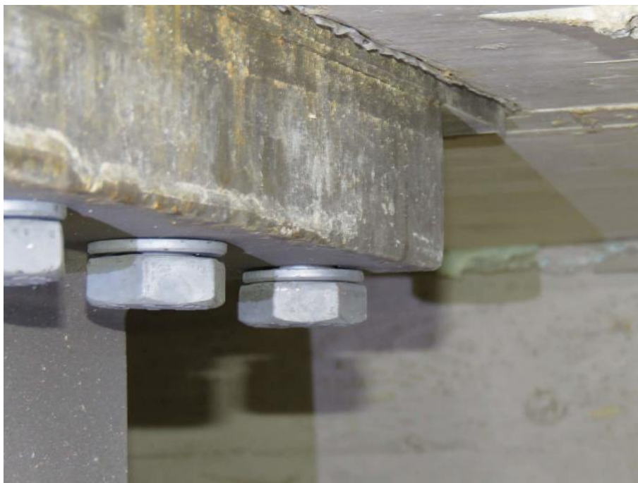
Slika 136: Neprivita sidrna vijaka.
