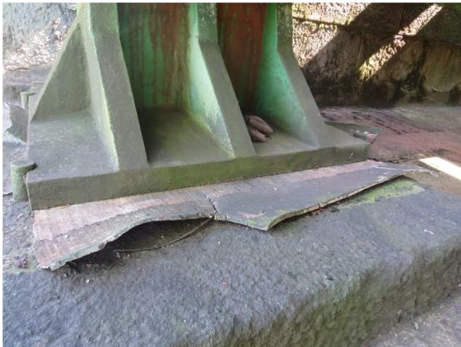
Slika 149: Iztiskanje svinčene plošče izpod linijskega nagibnega ležišča.
