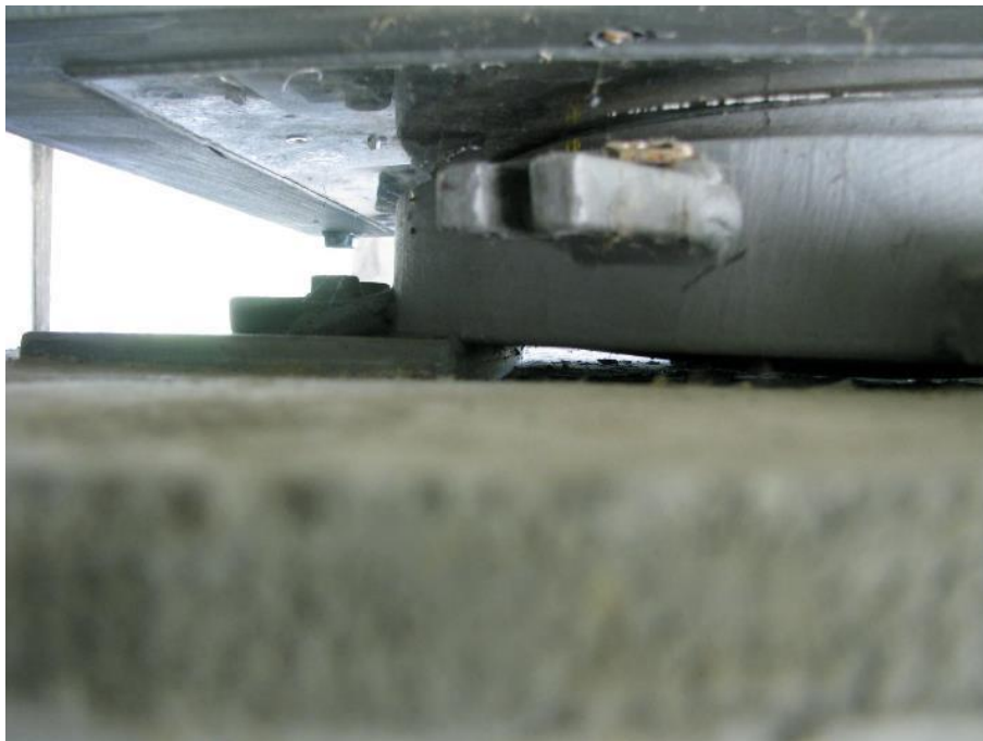
Slika 103: Deformacija dna lonca. Lončno ležišče polno obremenjeno, ko še ni bilo podlito.
