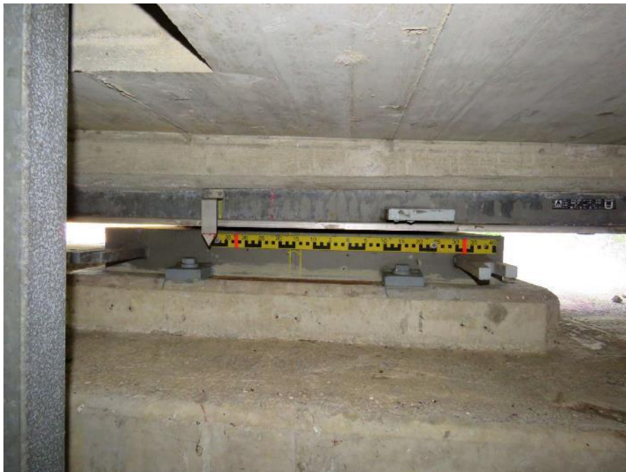
Slika 164: Napačno pritrjena merilna skala.
