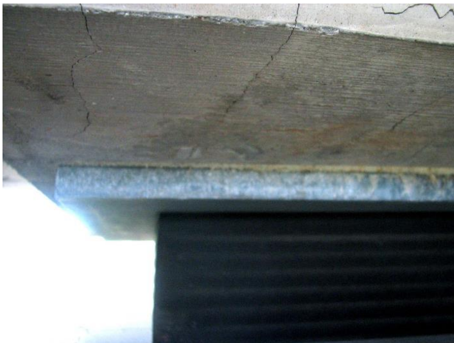
Slika 41: Razpoke v zgornji ležiščni blazini.
