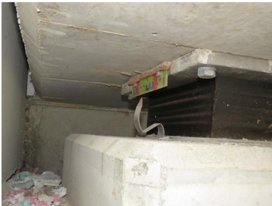
Slika 137: Deformiran kazalec pomikov.
