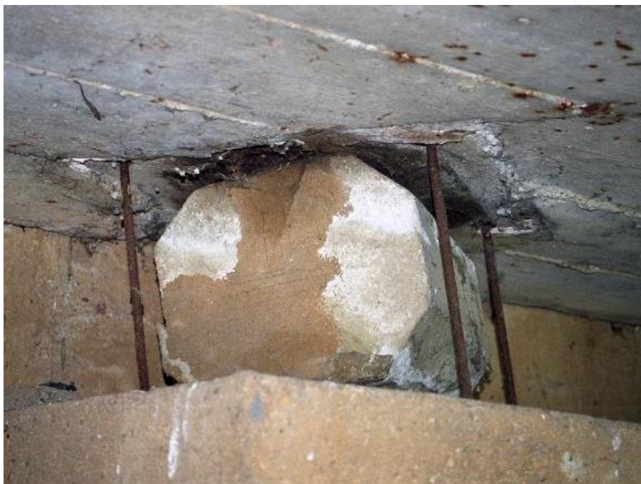
Slika 150: Betonsko valjčno ležišče.
