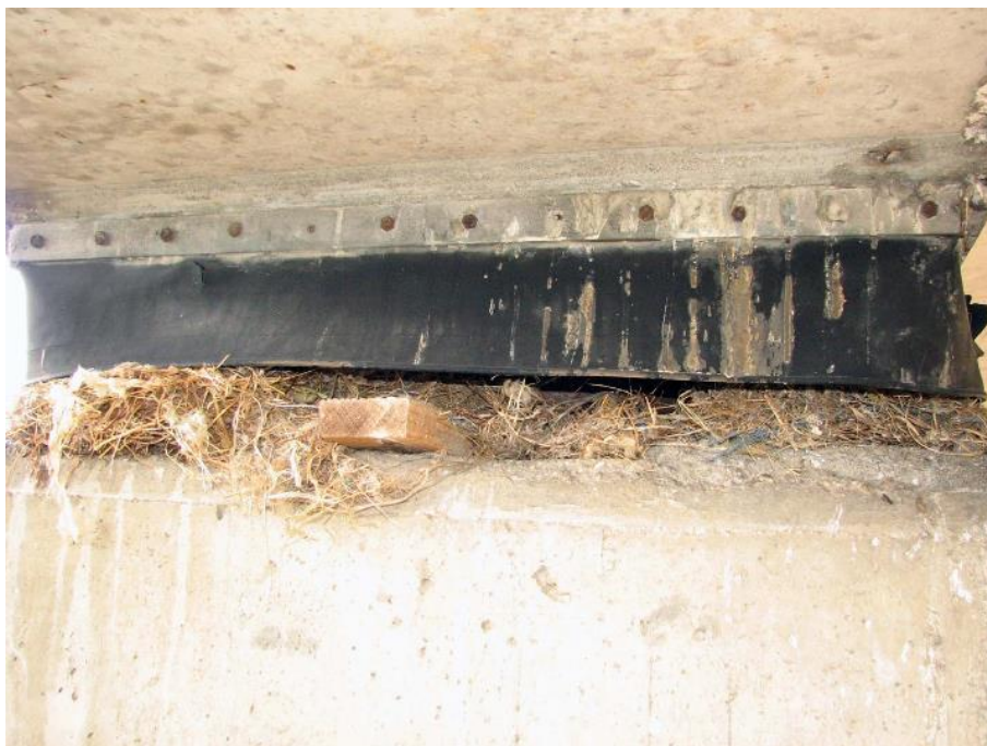
Slika 77: Ptičje gnezdo pod nezaščiteno drsno površino.
