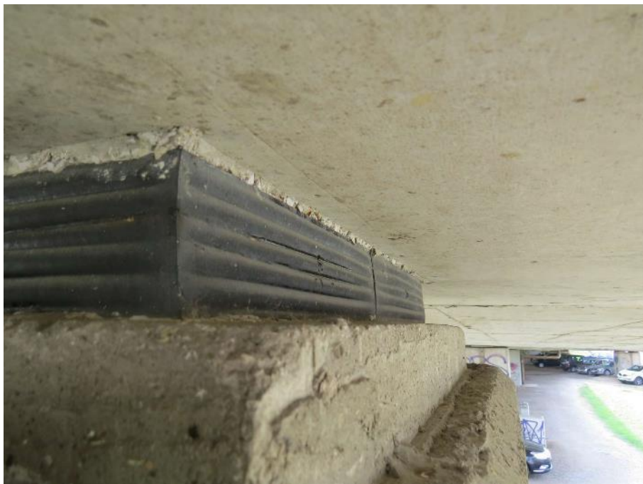
Slika 18: Razpoke elastomerja v nivoju jeklenih plošč.
