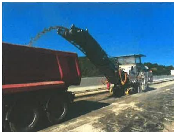
Slika 8.2: Priprava betonske površine c)
