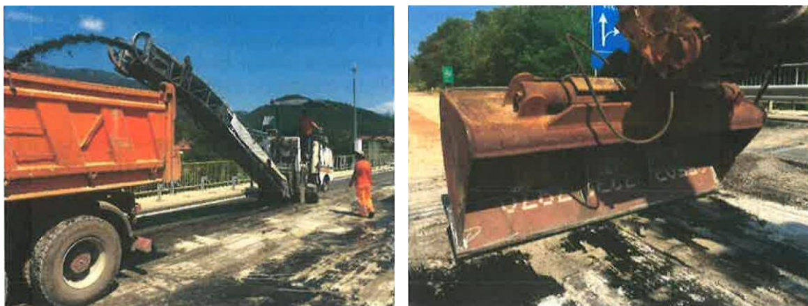
Slika 8.1: Priprava betonske površine a) in b)
