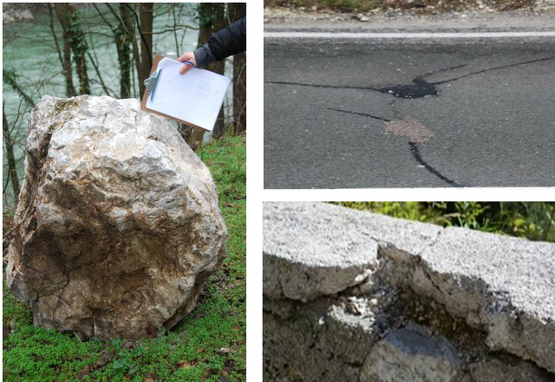
Slika 12: »Nema priča« in poškodbe na cesti in zidu ob udarcu skale
