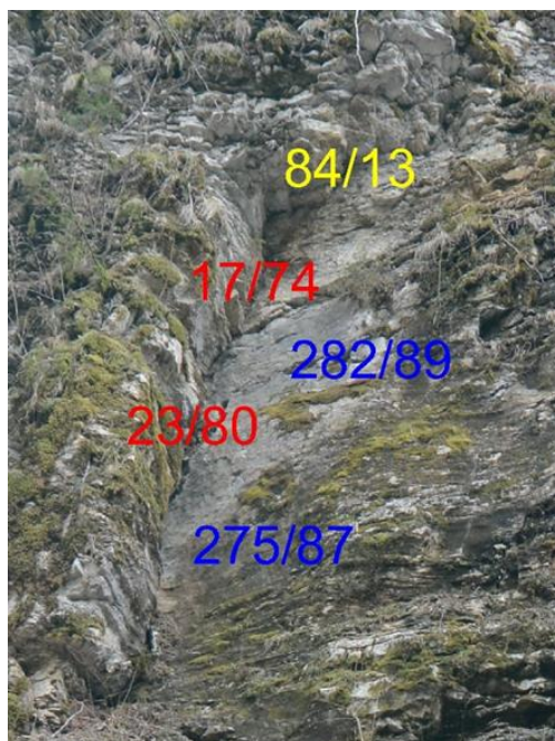
Slika 5: Meritve vpada treh izrazitih sistemov razpok (s tehnologijo aerofotogrametrije), ob katerih je prišlo do klinastega zdrsa skalnega bloka
