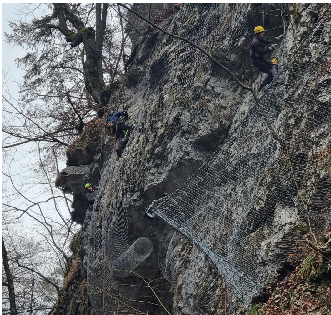
Slika 24: Prikaz polaganja prilagojenih mrež
