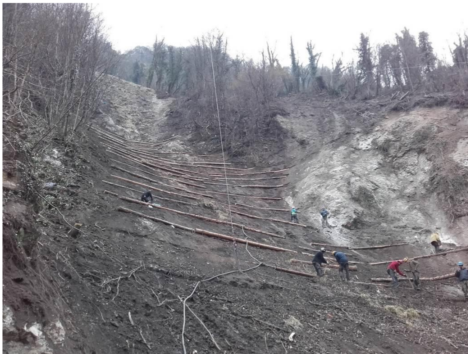
Slika 27: Biotehnična sanacija plaznice s sistemom sidranih lesenih oblic, z intenzivno zatravitvijo v seneni nastilj in s sidranimi mrežami. Po končani površinski zaščiti se je izvedlo popletanje vrbovih popletov, sajenje drevesnih sadik in podtikanje vrbovih potaknjencev po celotni površini plazu
