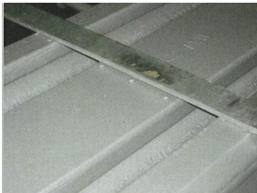
Slika 6.5: Jeklene udarne točke na zgornji površini lamel in robnih profilov v izogib strižnemu premiku pri prednastavitvi lamelne dilatacije
