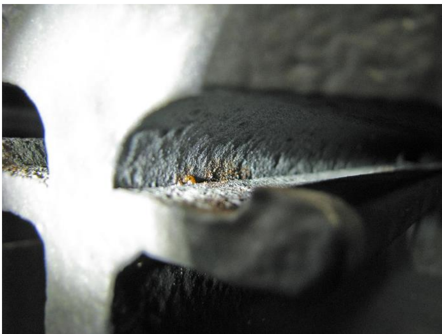
Slika 8.4: Kontrola izvedbe protikorozijske zaščite s premazi (v utoru ne sme biti razlite barve ter v celoti izveden osnovni premaz-brez ostankov korozije)
