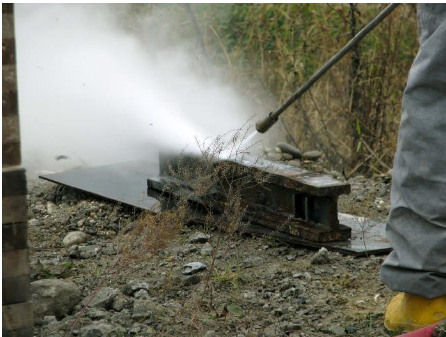
Slika 8.3: Čiščenje vodotopnih kloridov prečne grede z vodo pod visokim pritiskom
