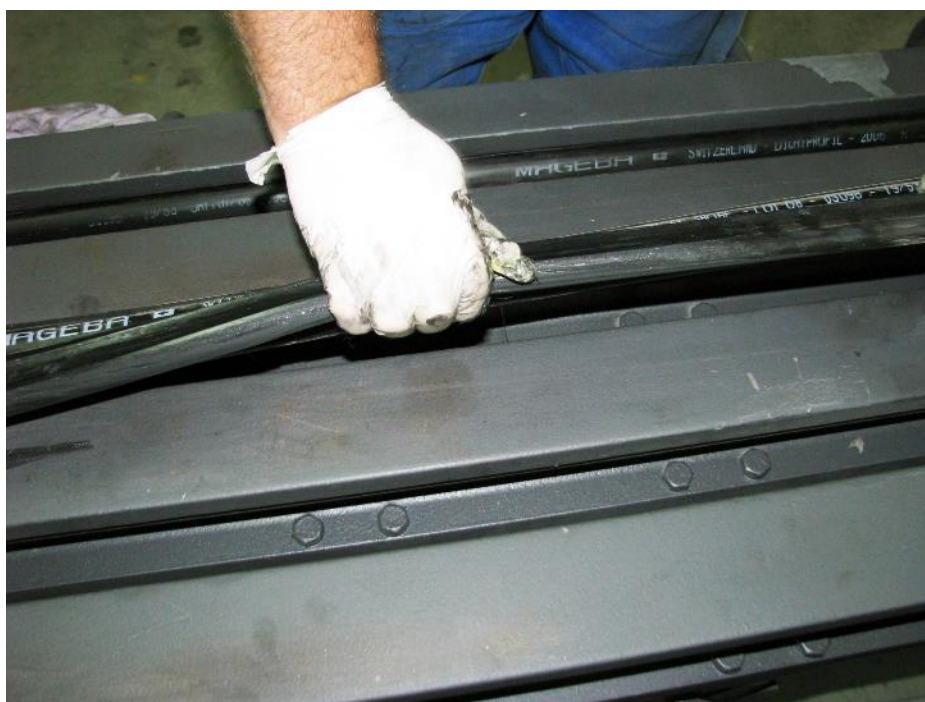
Slika 8.6: Vodenje tesnilnega traku v utor profila vmesne lamele
