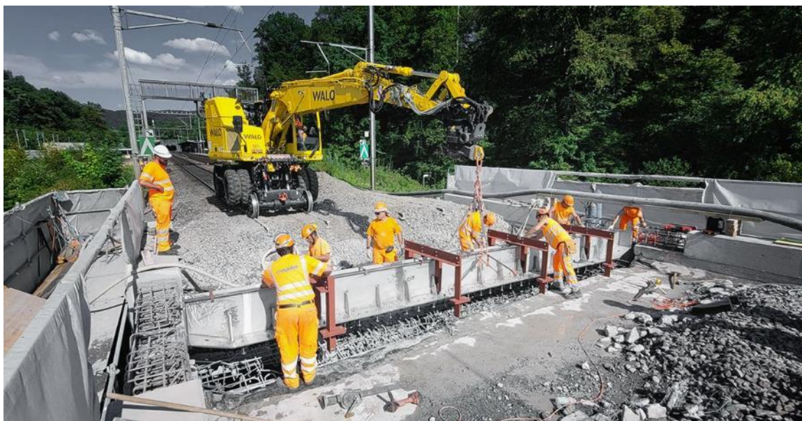
Slika 8.10: Zamenjava pokrite železniške drsne plošče - dilatacije z novo odprto konzolno jekleno dilatacijo (vir.: mageba in Scheffel AG Švica za SBB)
