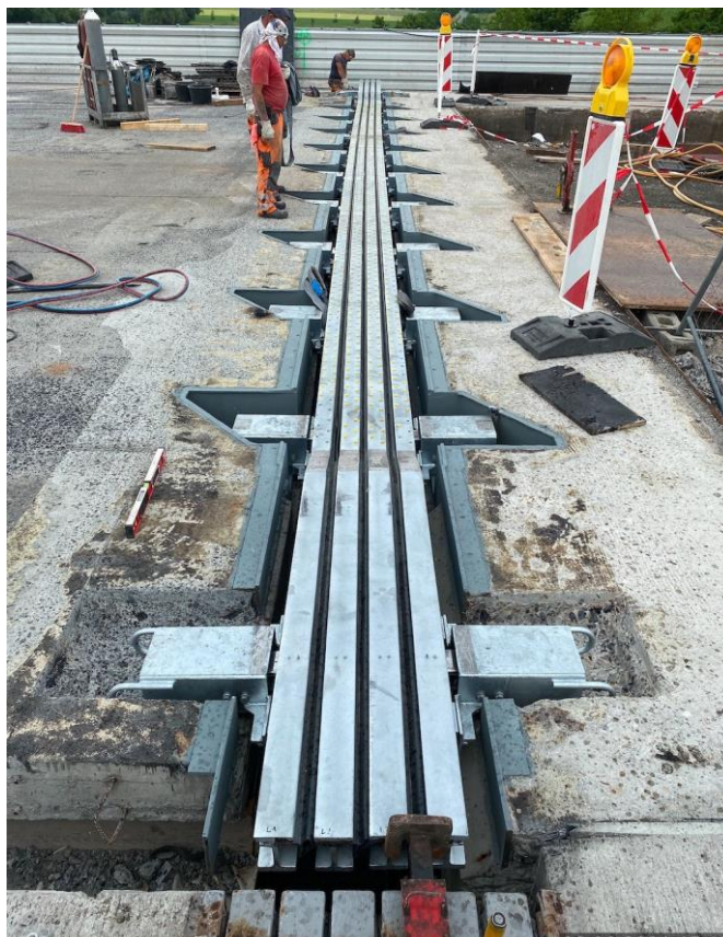
Slika 8.9: Zamenjava cestne lamelne dilatacije po sistemu »novi zabojniki v obstoječe zabojnike«
