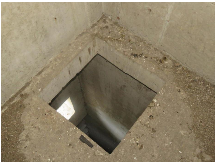
Slika 166: Nezaščiten dostopna odprtina na podest stebra. Površina podesta pokrita s ptičjimi iztrebki.
