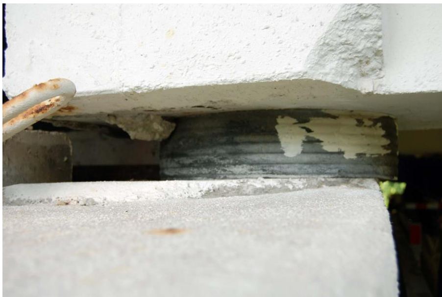
Slika 11: Zdrs elastomernega ležišča preko roba prečnega nosilca vmesne podpore. Ležišče vgrajeno preblizu roba prečnega nosilca.
