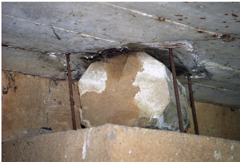
Slika 150: Betonsko valjčno ležišče.
