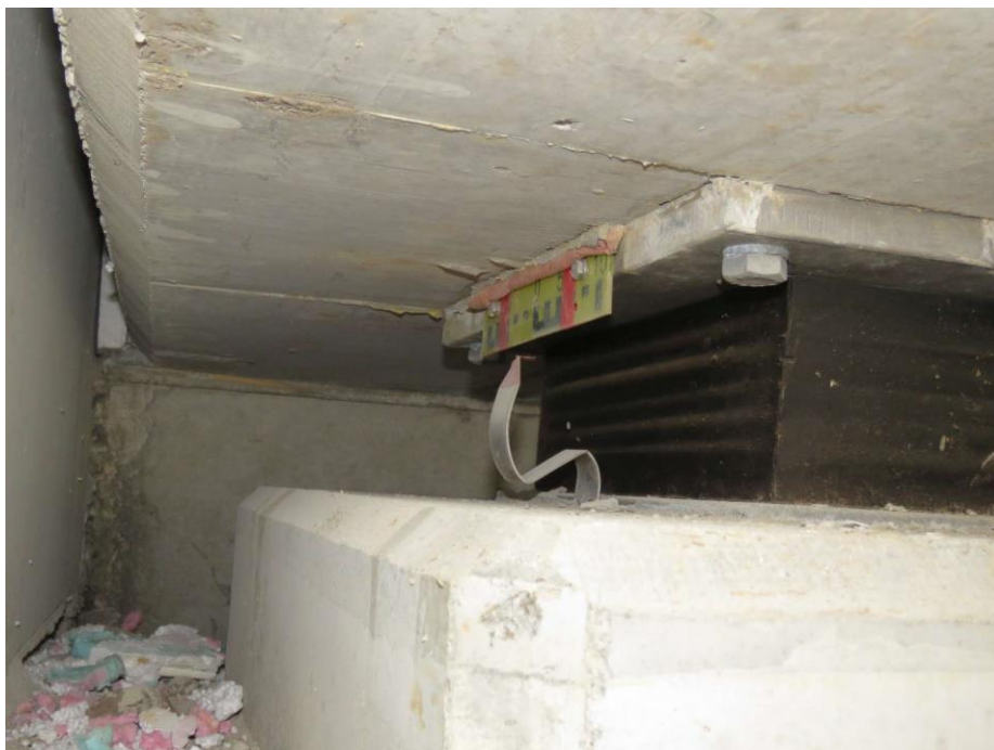
Slika 137: Deformiran kazalec pomikov.
