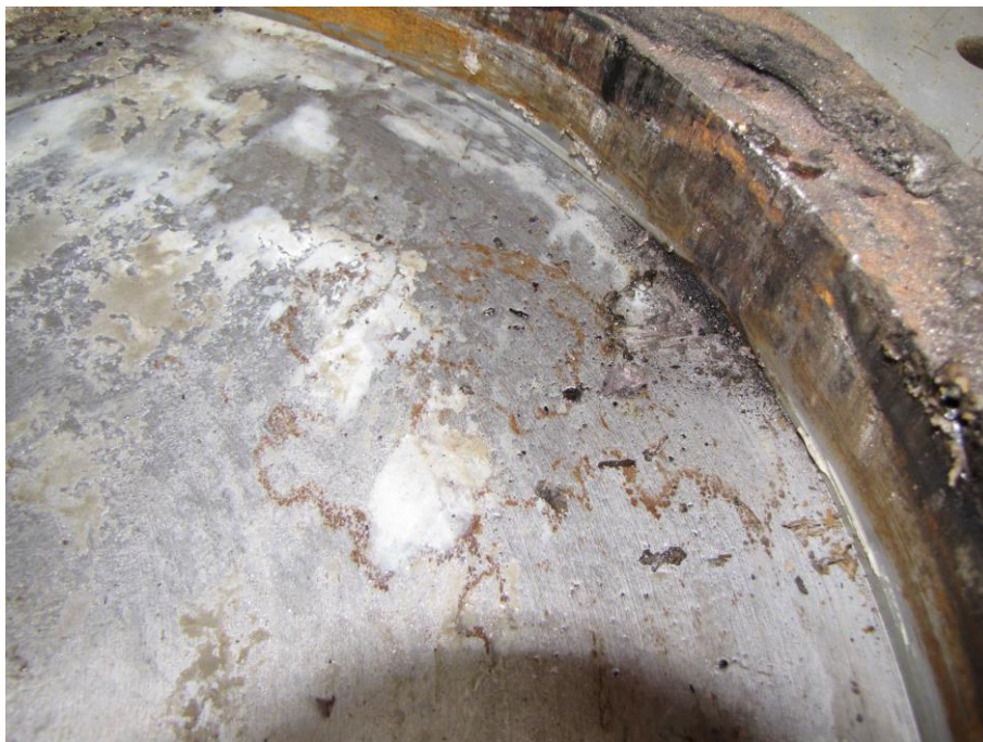
Slika 90: Dno in obod lonca na mestu iztiskanja elastomerne blazine.
