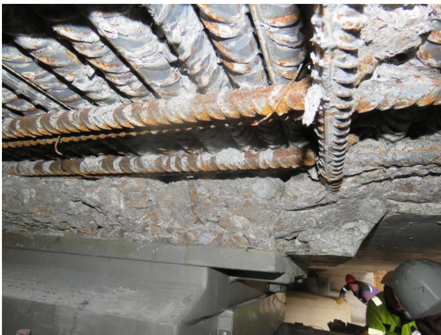
Slika 139: Gosta armatura prečnika ob in nad ležiščem.
