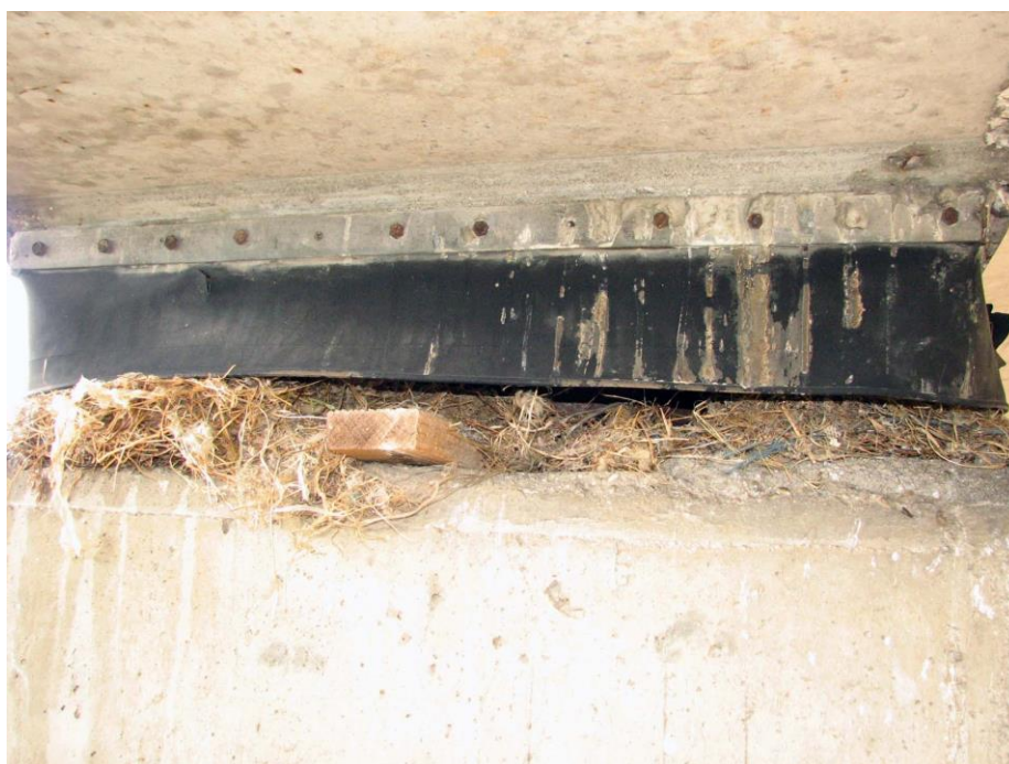
Slika 77: Ptičje gnezdo pod nezaščiteno drsno površino.
