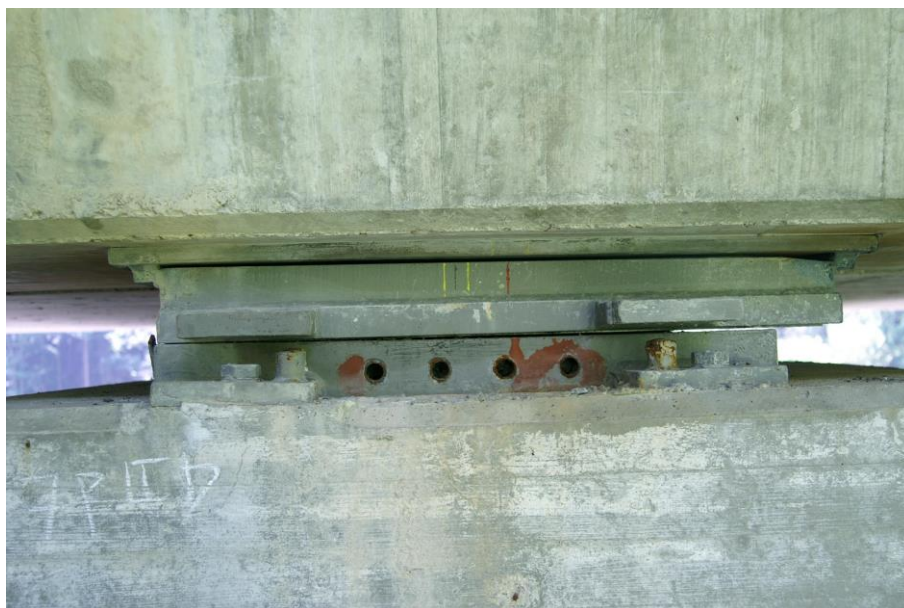
Slika 106: Kontakt bočnega vodila z loncem zaradi neustrezno podlitega ležišča.
