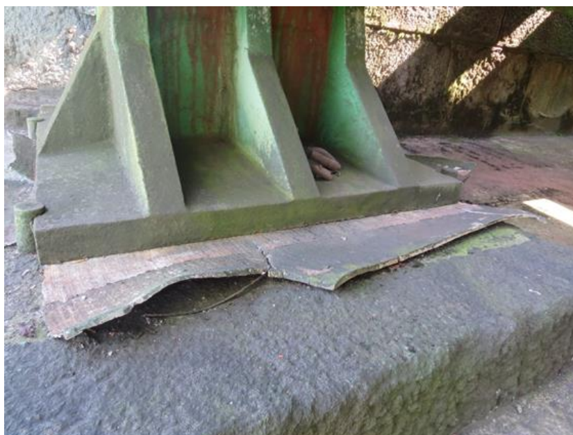
Slika 149: Iztiskanje svinčene plošče izpod linijskega nagibnega ležišča.
