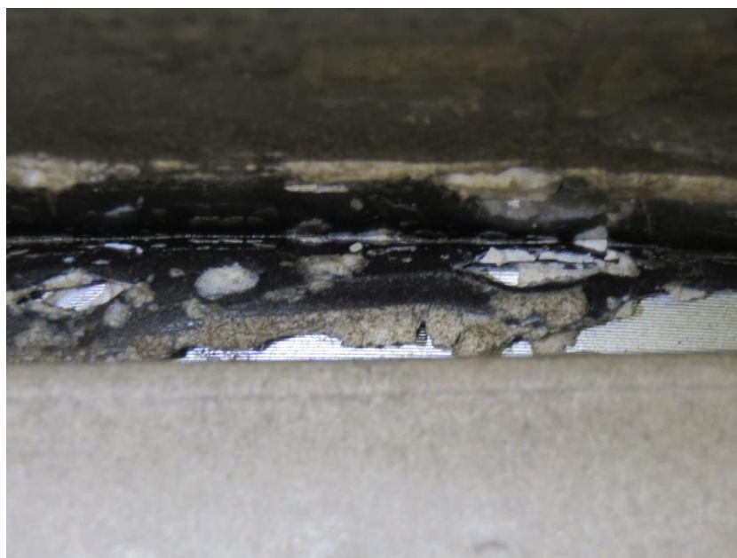
Slika 141: Izstiskanje MSM drsnega diska sfernega ležišča iz nosilnega ohišja – detajl.
