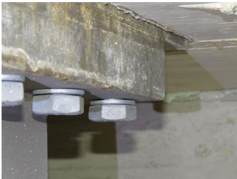
Slika 136: Neprivita sidrna vijaka.
