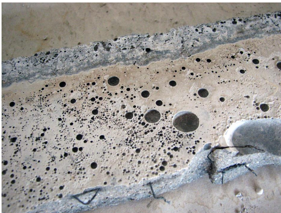
Slika 47: Zračni mehurji v kontaktni površini podlivne malte s prekladno konstrukcijo.
