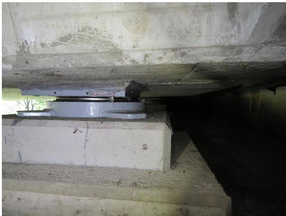
Slika 114: Prevelik pomik vodenega drsnega ležišča.
