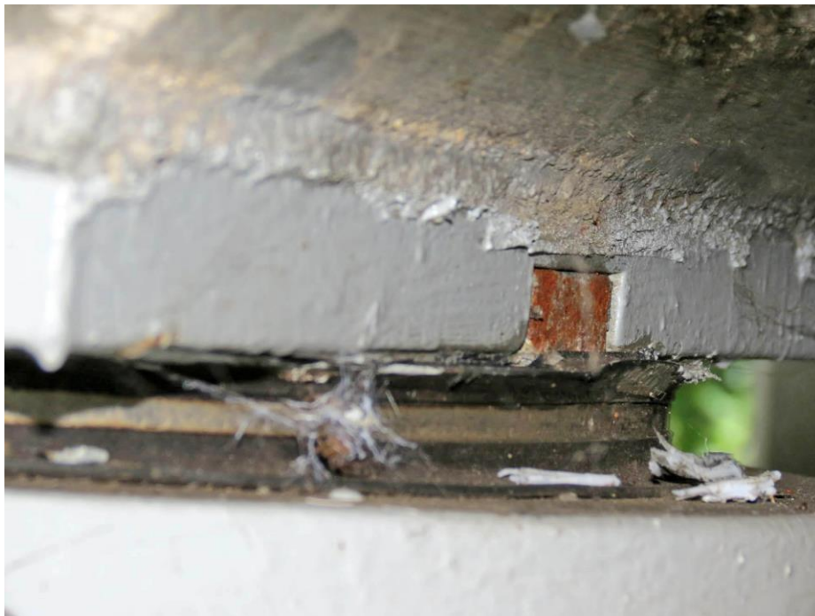
Slika 116: Prevelik pomik vodenega drsnega ležišča. Rob drsne plošče na drsnem disku. Struženje teflona.
