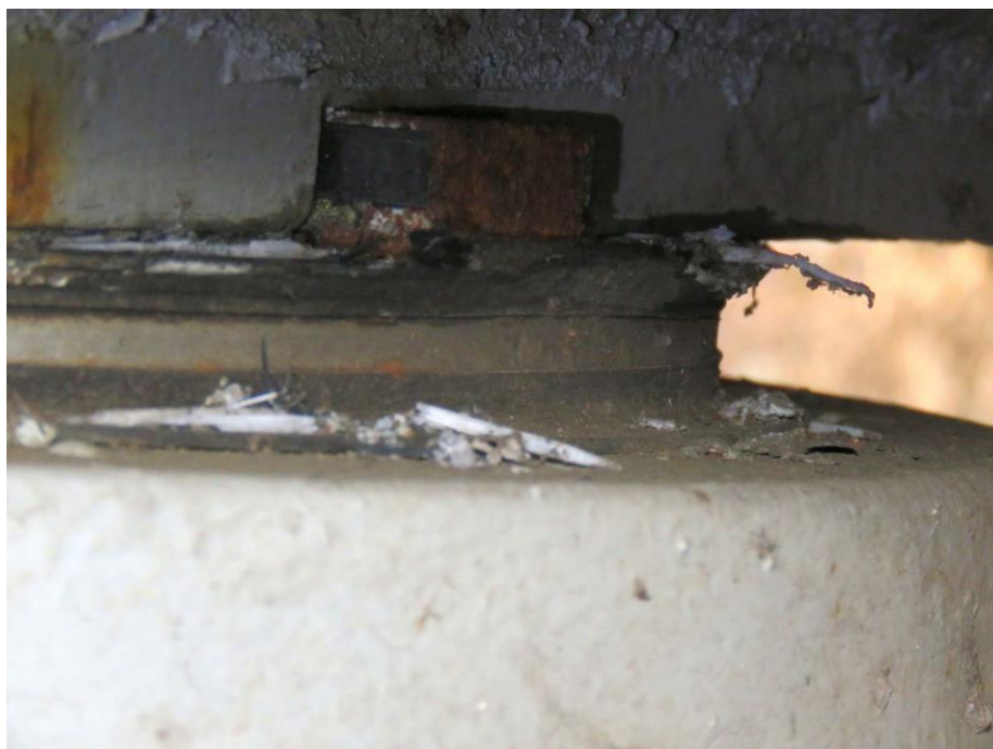
Slika 117: Prevelik pomik vodenega drsnega ležišča. Rob drsne plošče na drsnem disku. Struženje teflona.
