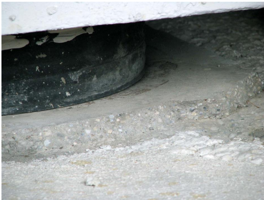
Slika 12: Zdrsavanje ležišča iz predhodne slike po ležiščni blazini iz malte.
