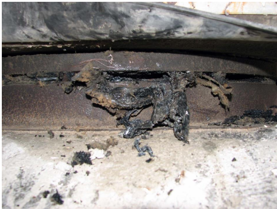
Slika 84: Iztiskanje elastomerne blazine iz lonca lončnega ležišča.
