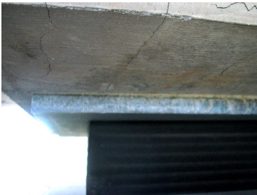
Slika 41: Razpoke v zgornji ležiščni blazini.
