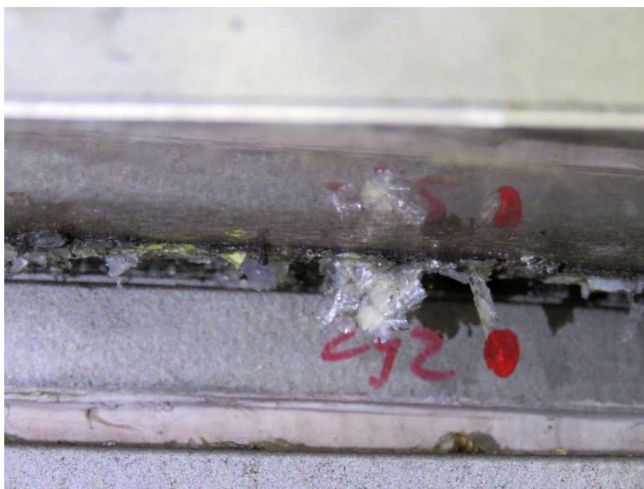
Slika 131: Struženje teflona drsnega diska lončnega ležišča.
