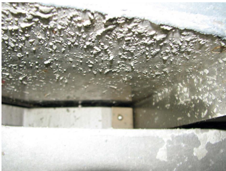
Slika 109: Umazana drsna površina z betonskim obrizgom.
