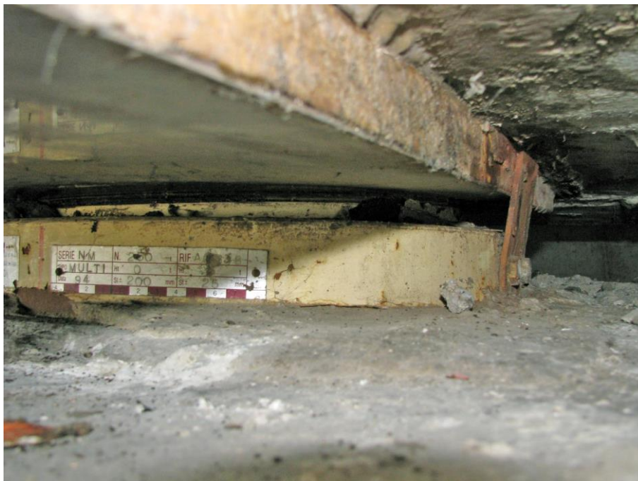
Slika 104: Iztiskanje elastomerne blazine iz lonca lončnega ležišča.
