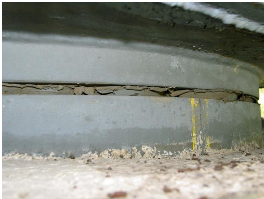
Slika 113: Propadanje tesnilnega traku nagibne reže.
