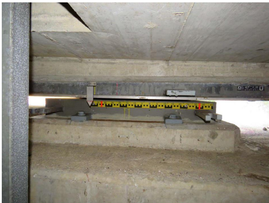
Slika 164: Napačno pritrjena merilna skala.
