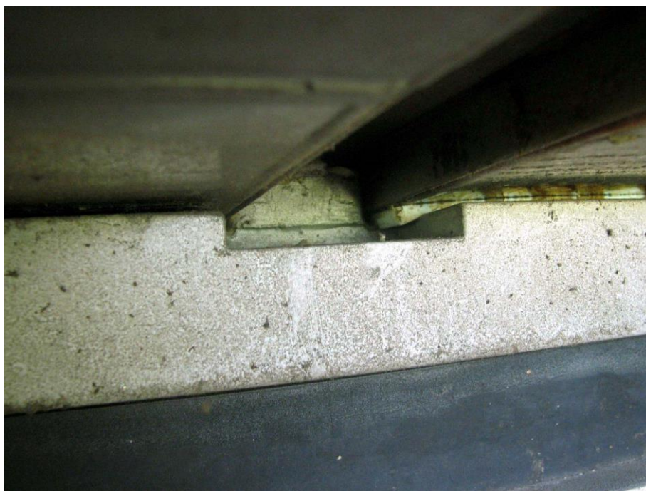
Slika 75: Izstiskanje teflona iz utora zgornje nosilne plošče deformabilnega drsnega ležišča.
