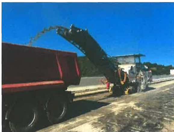
Slika 8.2: Priprava betonske površine c)
