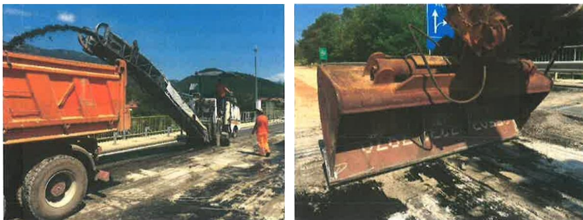
Slika 8.1: Priprava betonske površine a) in b)
