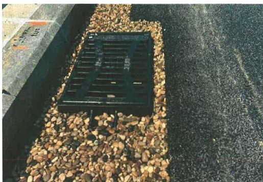
Slika 8.19: Drenažni filtrni žleb
