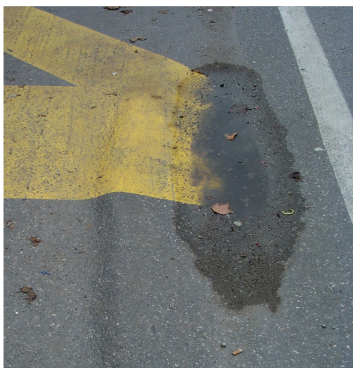
Slika 13: Preoblikovanje vgrajene asfaltne zmesi – grbina ob kadunji
