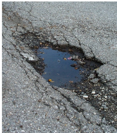
Slika 8: Razgraditev asfaltna zmesi – udarna jama
