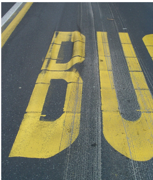
Slika 11: Prečno preoblikovanje vgrajene asfaltne zmesi – kolesnici
