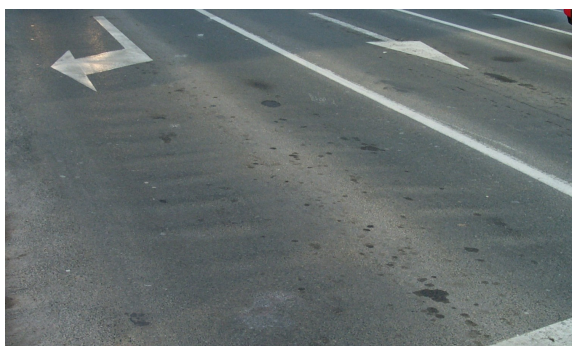
Slika 12: Vzдолžno preoblikovanje vgrajene asfaltne zmesi - perilnik
