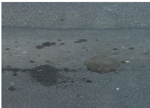
Slika 10: Razgraditev asfaltna zmesi – lokalni učinki derivatov nafte
