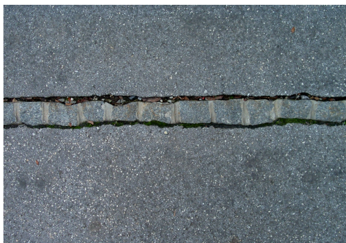
Slika 2: Razpoke na stikih asfaltnih zmesi z drugačnimi materiali (obroba s kamnitimi tlakovci)
