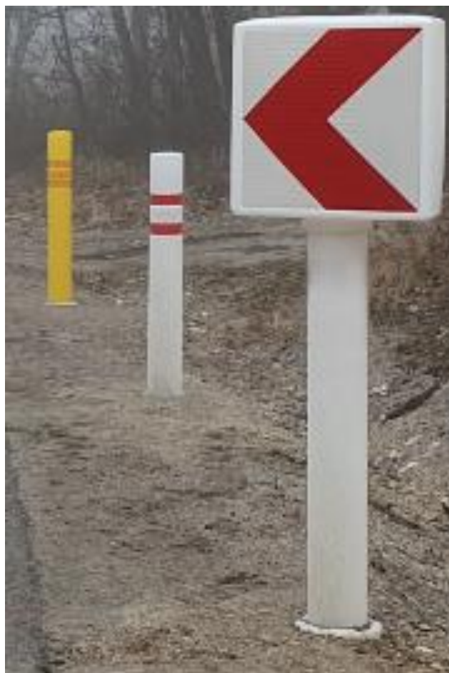
Slika 20 in 21: Odmik obojestranskega znaka za usmerjanje prometa v ovinkih na PVS od roba vozišča (vir: R. Strah).
