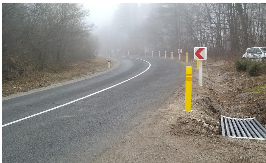
Slika 33: Prikaz primera dobre prakse z ustrezno označitvijo krivine in priključkov s preostalimi varnostnimi elementi za motoriste (vir: R. Strah)
