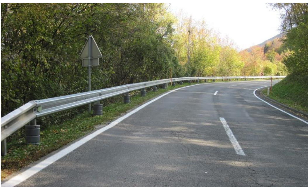
Slika 10: Pravilno nameščen BTM na steber JVO (vir: B. Matko in U. Brumec).
