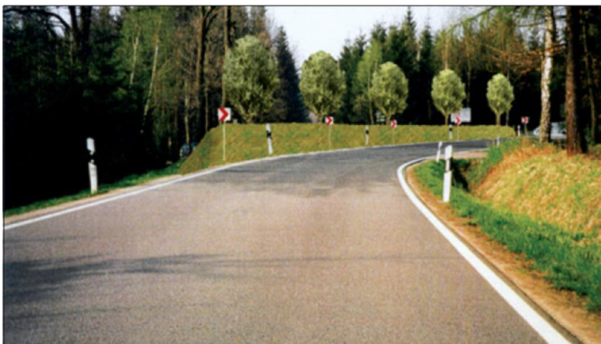
Slika 29: Izvedba nasipa vzdolž krivine z ozelenitvijo z namenom boljšega vodenja motoristov skozi krivino (Vir: World Road Association – PIARC: Road Safety Manual)
