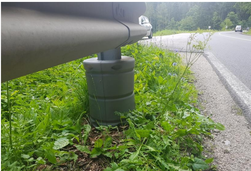
Slika 9: Pravilno nameščen BTM na steber JVO (vir: B. Matko in U. Brumec).
