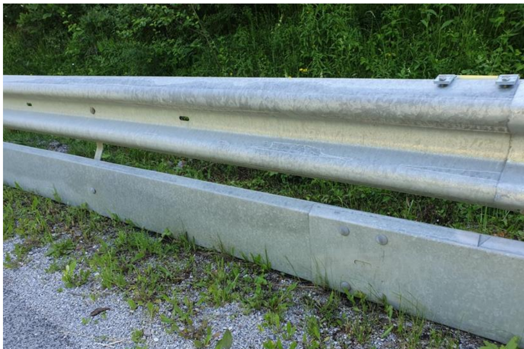
Slika 3: Pravilna izvedba dodatne zaščite za motoriste na JVO (vir: T. Tollazzi).
