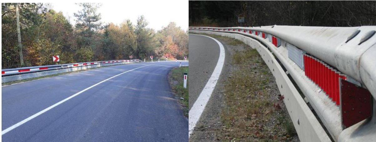
Slika 27 in 28: Povečanje zaznavnosti ovinka v nočnem času: rdeče-beli trakovi za usmerjanje v ovinkih v kombinaciji z JVO z dodatno zaščito za motoriste in obojestranskimi znaki 3312 za usmerjanje prometa v ovinkih (Vir: U. Brumec)
