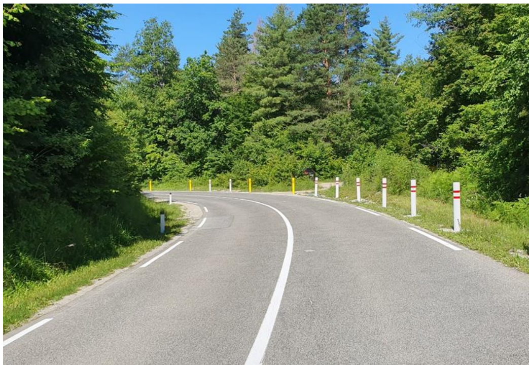
Slika 15: Pasivno varni stebrički na priključku (vir: T. Tollazzi).
