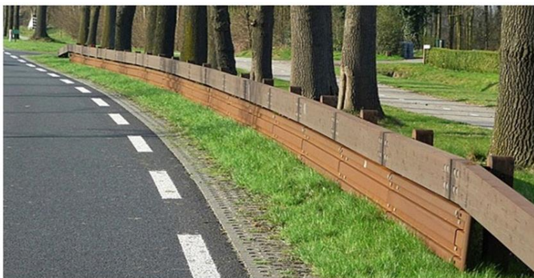
Slika 4: Pravilna izvedba dodatne zaščite za motoriste na LVO (vir: Eurorail BV - www.eurorail.nl ).
