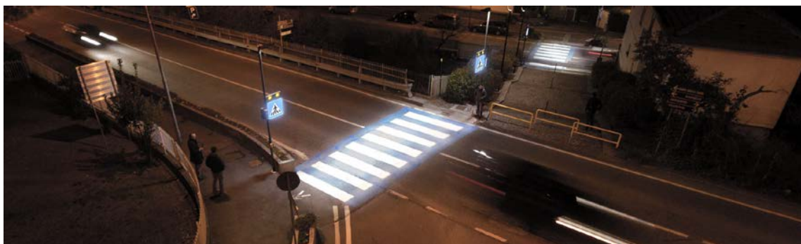
Slika 7. Dodatna osvetlitev prehoda za pešce z dvema svetilkama in opazno večja svetlost horizontalne površine območja prehoda. Pri prehodu na sliki je dodaten kontrast dosežen še z barvanjem okolice zebre z modro barvo.
