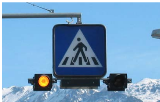
Slika 13. Znak za prehod za pešce, nameščen nad prehodom in opremljen z dvema stalno utripajočima rumenima lučema, kot je pogosta uporaba v Sloveniji. Opomba: način uporabe rumene utripajoče luči, kot je prikazan na sliki, ni več dovoljen – glej Pravilnik o prometni signalizaciji in prometni opremi na cestah (PPSPOC – Uradni list RS, št. 99/15, in 46/17, 59/18 in 63/19)
