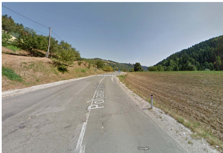
Slika 2. Primer regionalne ceste, kjer je prehod za pešce, ki ga je treba osvetliti
