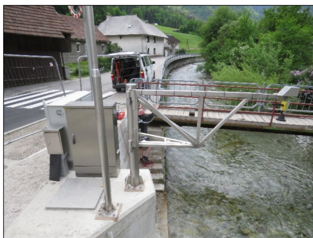
Slika 6: Hidrološka postaja v Črni; vir: ARSO
