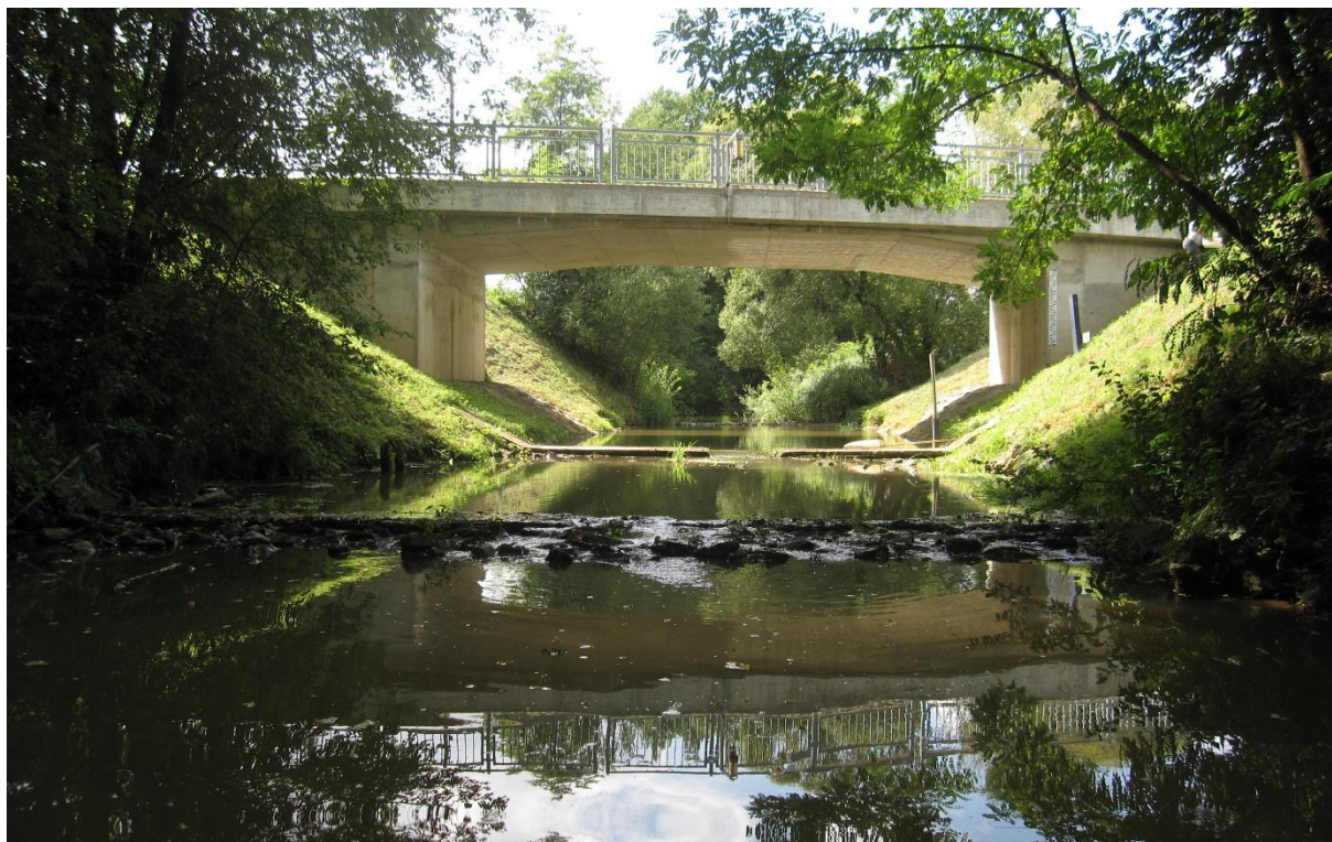
Slika 5. Velika Krka na Hodošu s hidromorfološko spremenjeno strugo in bregovi, foto: arhiv ARSO
