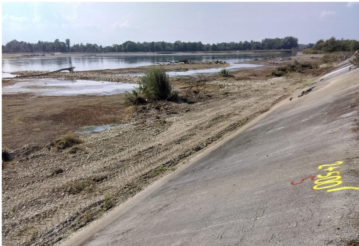
Slika 8. Zadrževalnik Ormoško jezero ob sanaciji leta 2016, foto: arhiv ARSO
