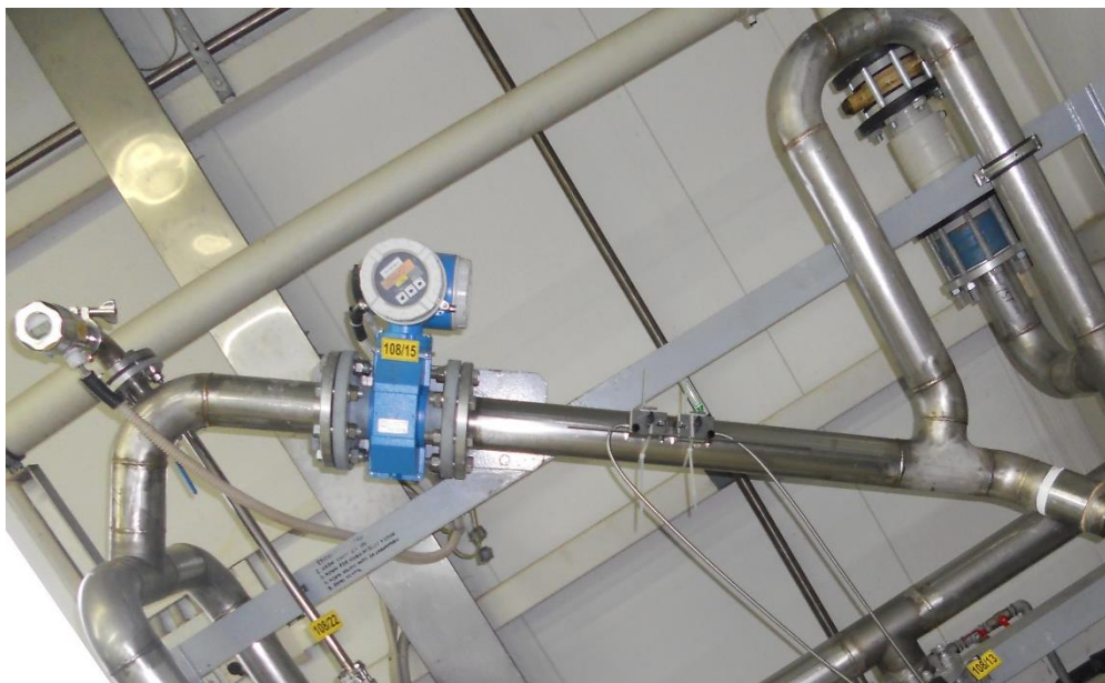
Slika 3: Meritev pretoka odpadne vode v zaprtem, tlačnem cevovodu. Smer toka odpadne vode je iz nižje na višjo točko (tlačni vod) v cevovodu, saj le na ta način lahko vedno zagotovimo cev napolnjeno z vodo.
