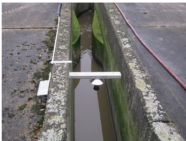
Slika 4: Ultrazvočni merilnik razdalje do gladine vode pri Venturijevem merskem kanalu
