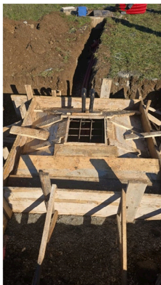
Izdelava enega od novih temeljev in jaška na Letališču E. Rusjana Maribor
