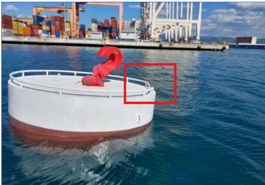
Posnetek privezne boje, poškodba v redečem kvadratu
