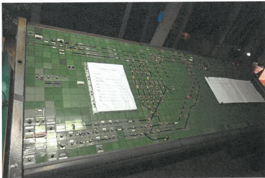
Slika št. 13: Prikazuje postavljalno mizo ERSV naprave postaje Zidani Most.
